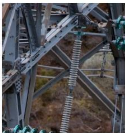
Joonis 2.2 Traaversi terasprofiilid. Kahene profiil 20 meetrisel traaversil (vasakul) ja ühene profiil 18 meetrise traaversil (paremal).
