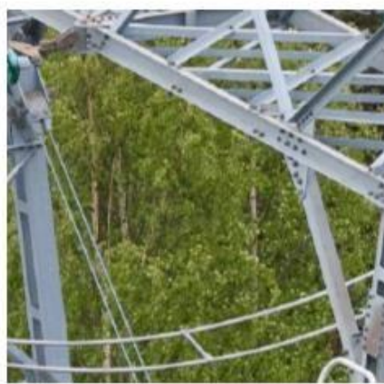
Joonis 2.2 Traaversi terasprofiilid. Kahene profiil 20 meetrisel traaversil (vasakul) ja ühene profiil 18 meetrise traaversil (paremal).
