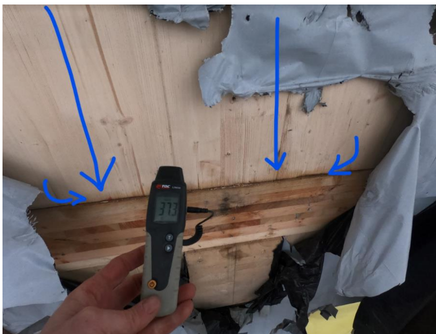
Joonis 28 - Mäepealse tn 3 seina/vahelae CLT liitekohta konstruktiivne sõlm
