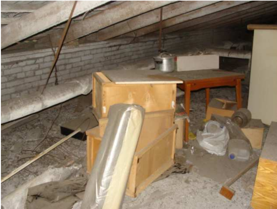
Joonis 5. Kangru 4 pööningu seisukord enne renoveerimist
