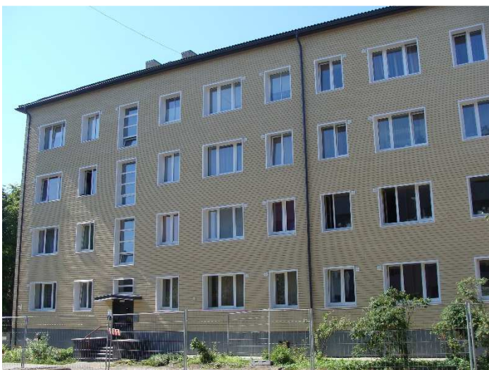
Joonis 6. Kangru 4 fassaad peale renoveerimist.
