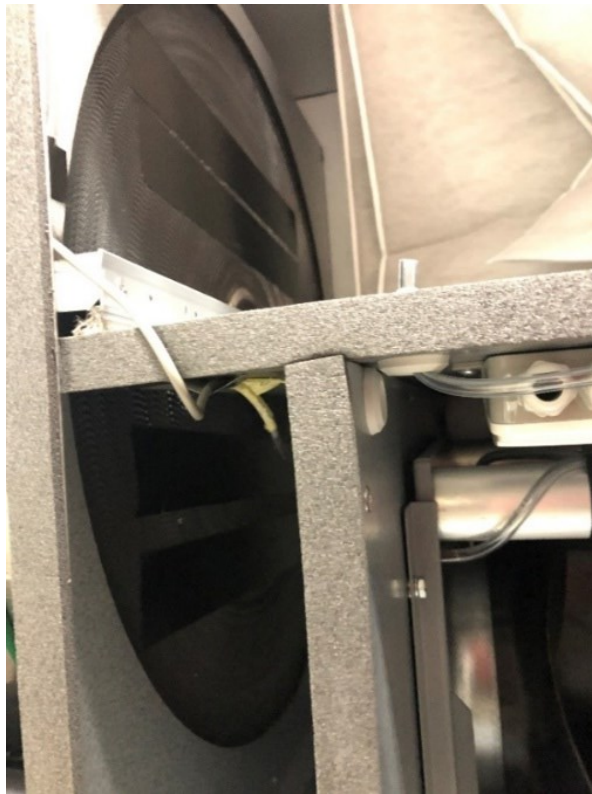
Foto 2. Rootorsoojusvaheti teipimine
