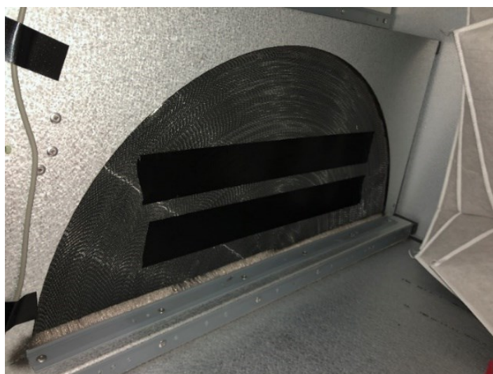
Foto 1. Rootorsoojusvaheti teipimine
