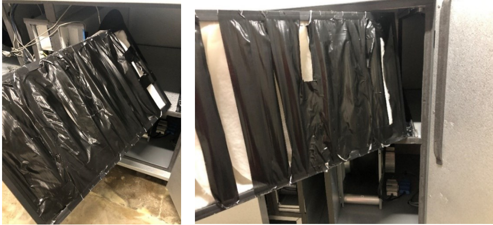
Foto 4. Filtri teipimine, et tõsta väljatõmbe poolel rõhku
