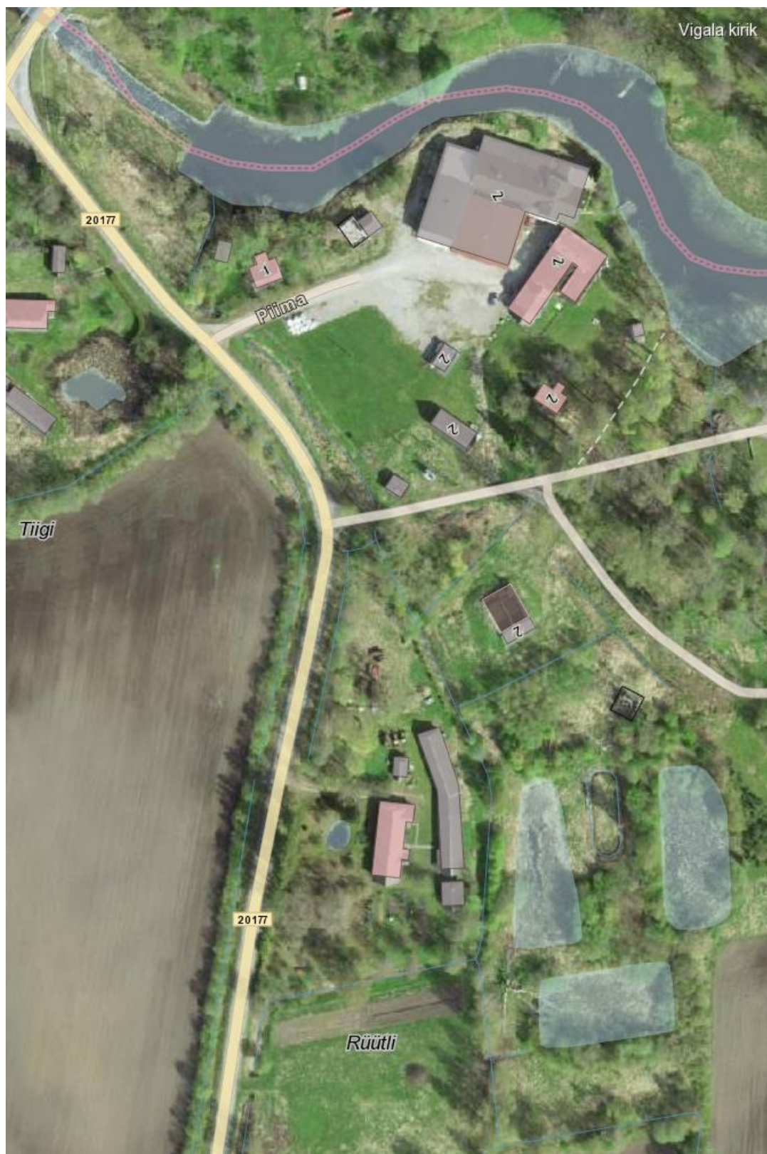
Joonis 5.15.1. Vigala Piimatööstuse reoveepuhasti ortofoto väljalõige [16]
