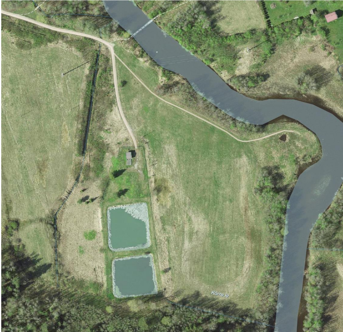
Joonis 5.7.1. Sipa reoveepuhasti ortofoto väljalõige [16]
