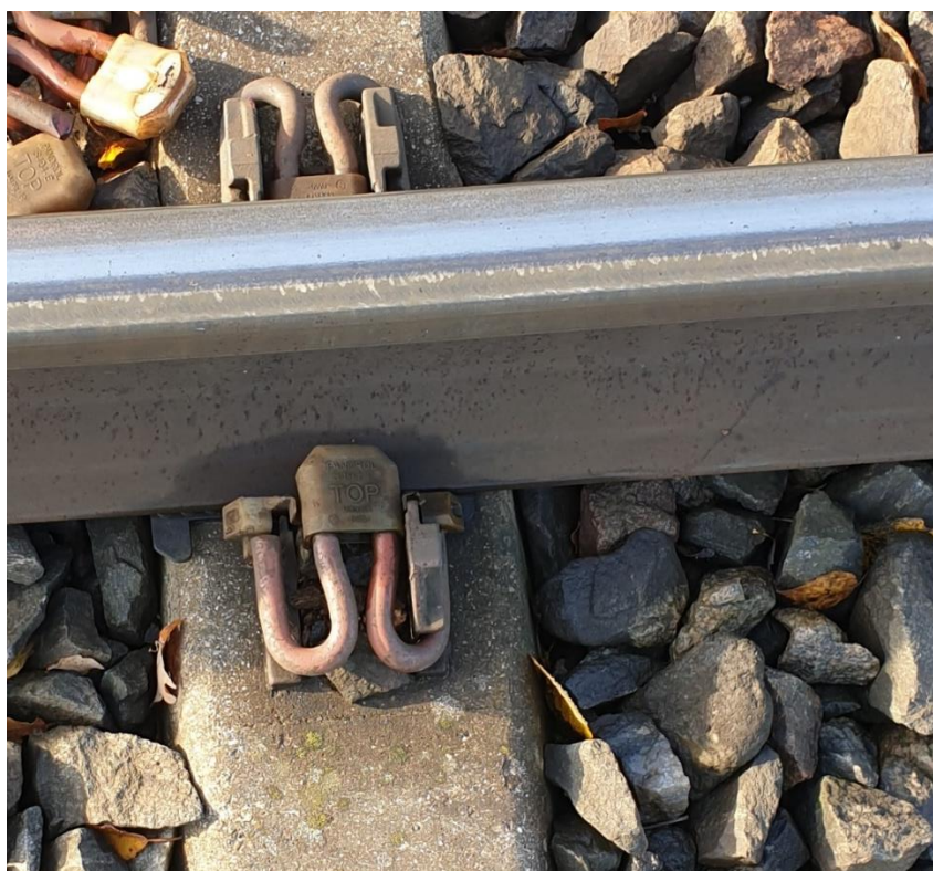
Joonis 15. Aluskummi asetus ja üldine seisukord pärast kümne aasta möödumist [Erakogu]
