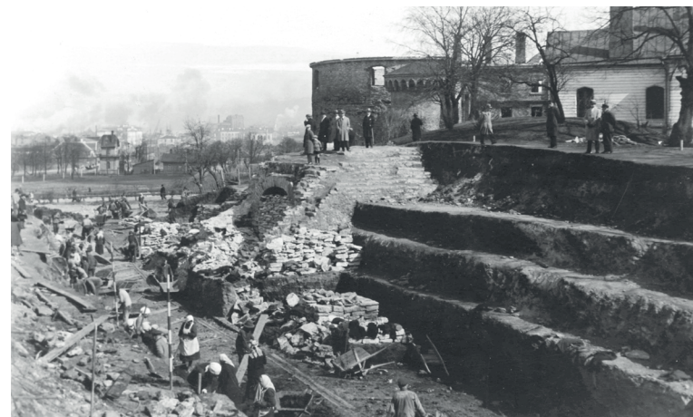
Joonis 17. Rannamäe tee ehitus läbi Skoone bastioni muldkeha 1931. aastal. Allikas: Kunstiajalooline fotokogu.
