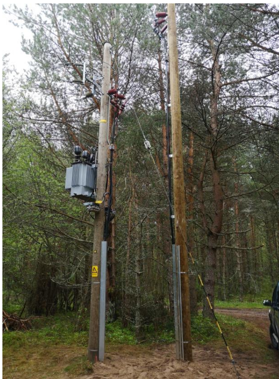
Joonis 15 Paigaldatud mast ja teostatud ühendused
