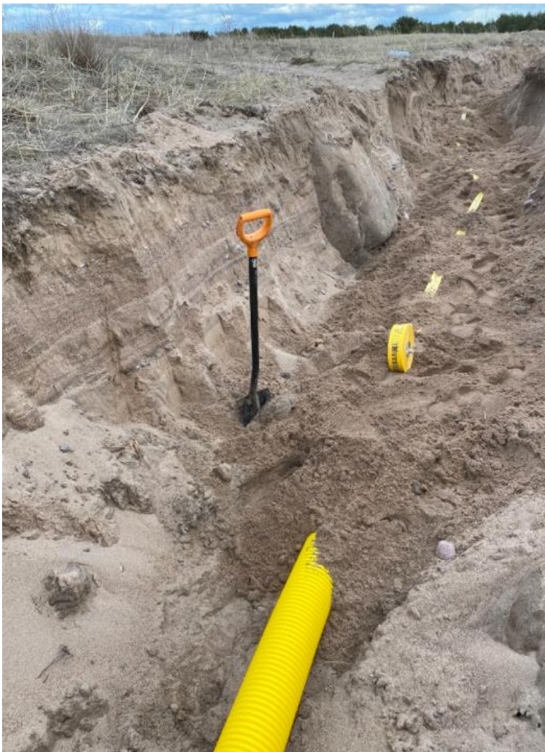
Joonis 9 Kaitsetoru paigaldamine
