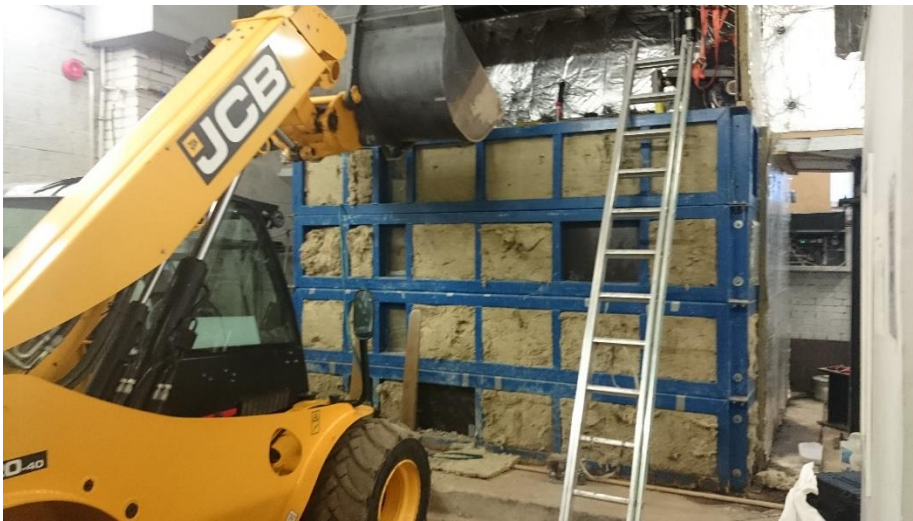
Joonis 7.2 TTK katsestendi ja aluse ehituseks kasutatud JCB teleskooplaadur
