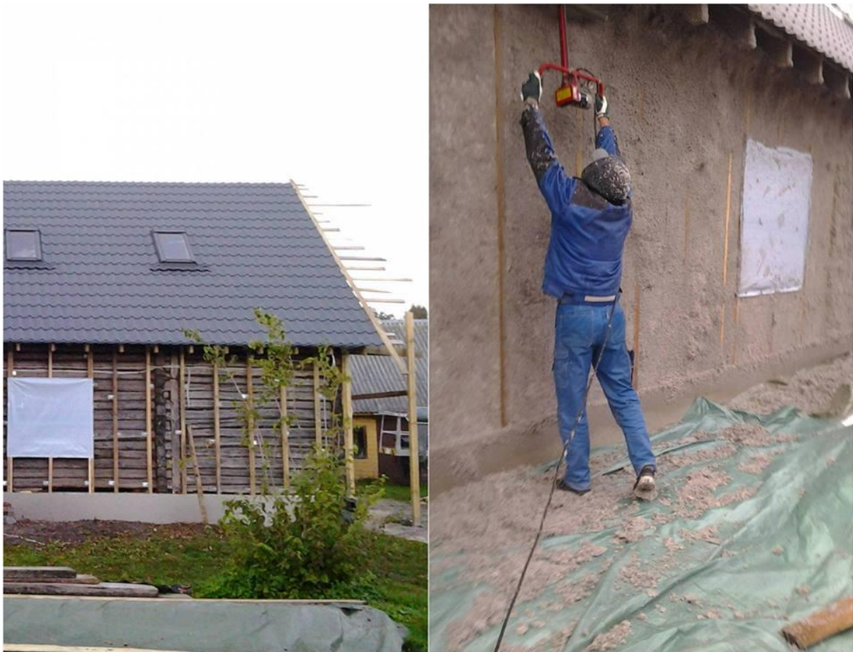
Joonis 5. Kalurikodu palkseinte rihtimine ja soojustamine
