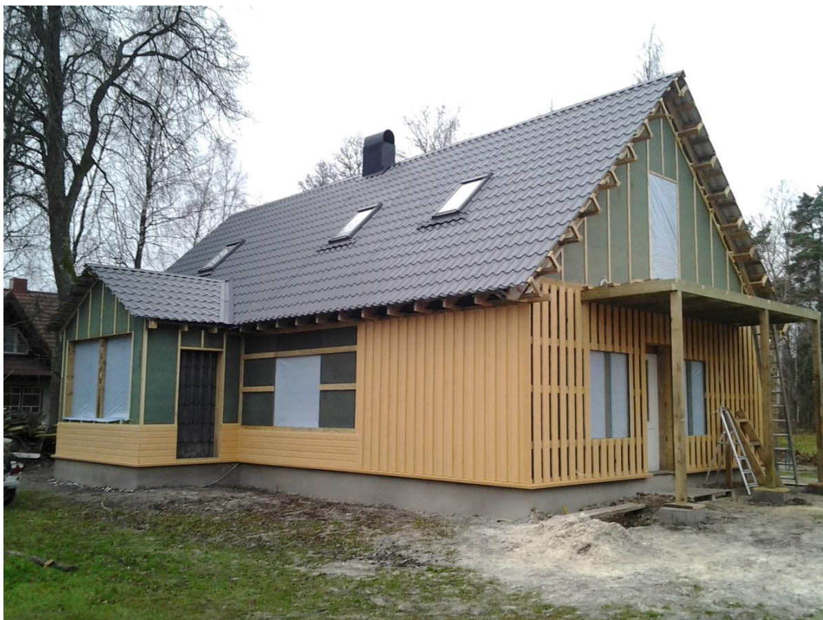
Joonis 6. Kalurikodu fassaaditööd.
