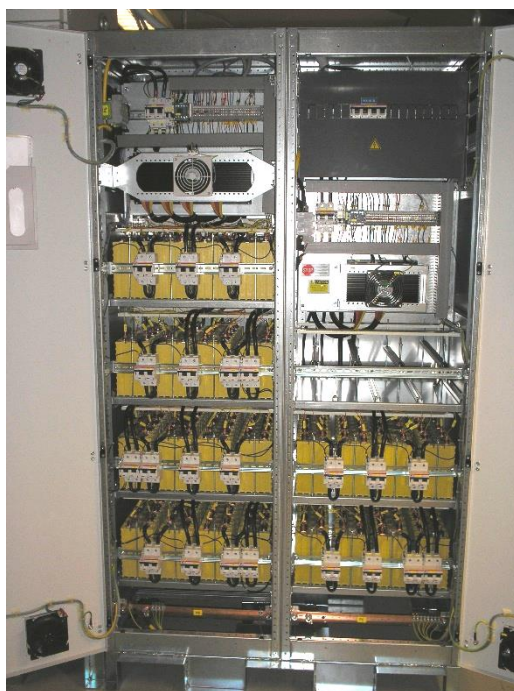
Joonis 3.3 Energiasalvesti akukapp
