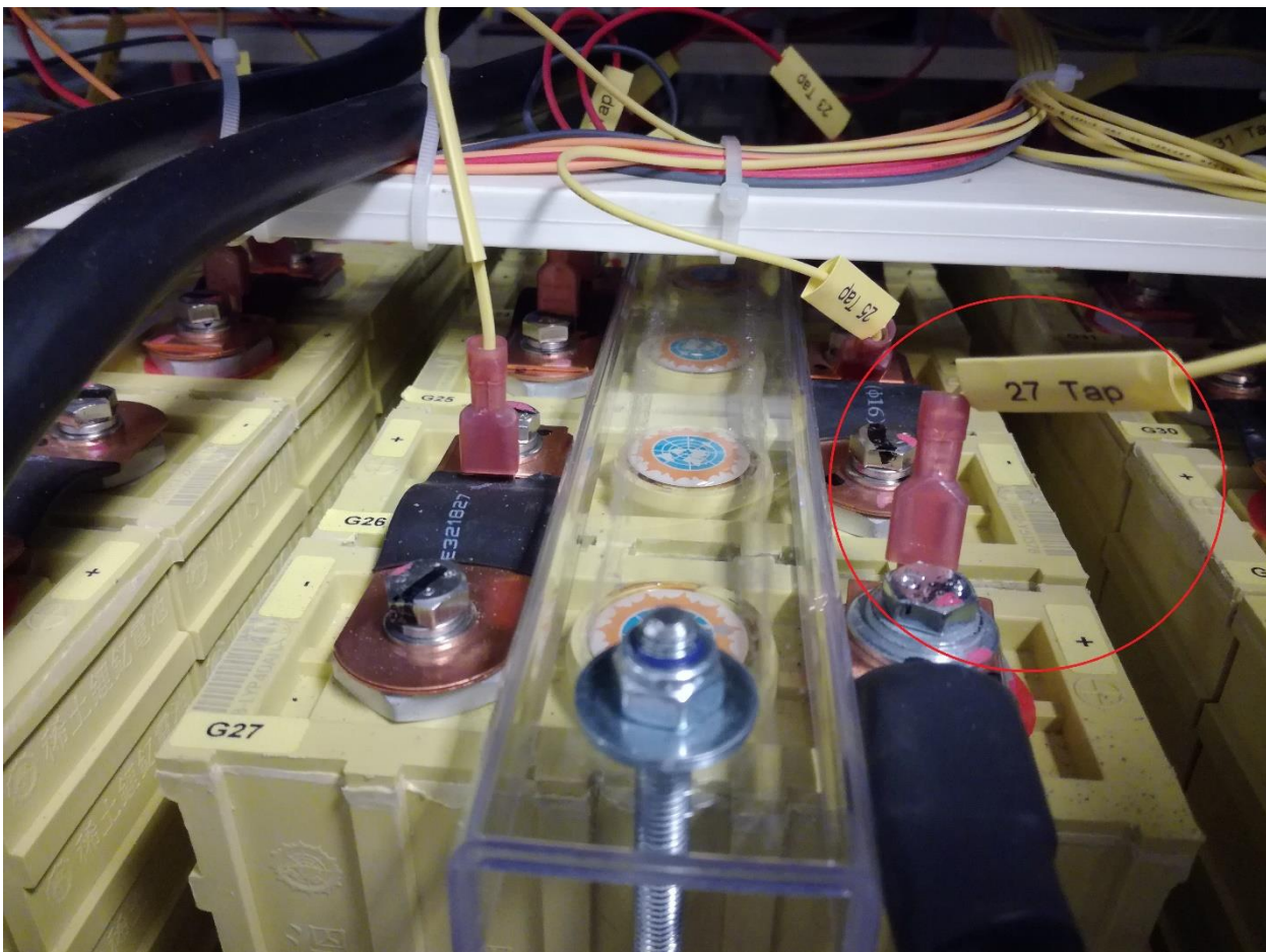
Joonis 4.18 Balansseerimissisendi ühendus akuelemendiga
