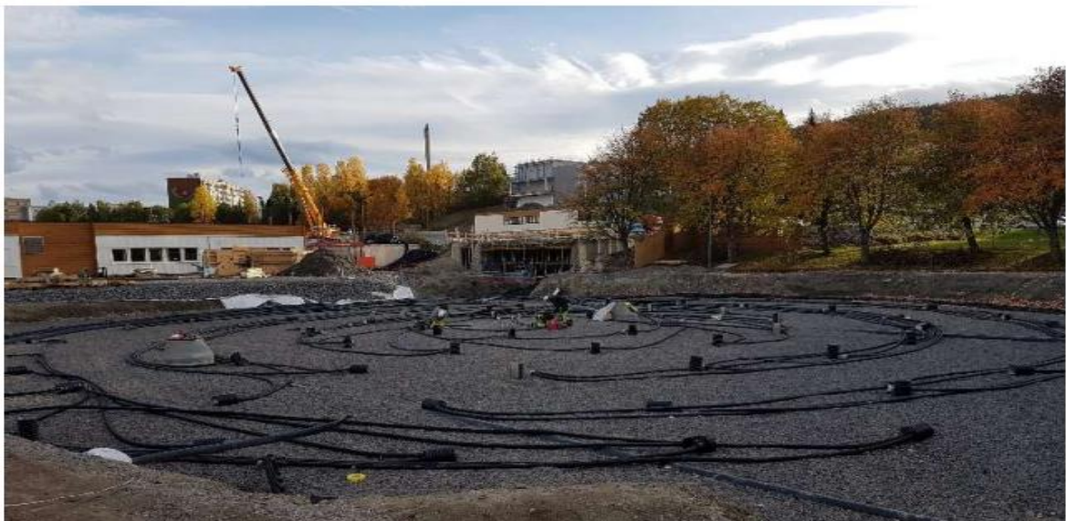
Joonis 9 Drammenis rajatav jaam kiudude paigaldamise ajal temperatuuri mõõtmiseks [21]
