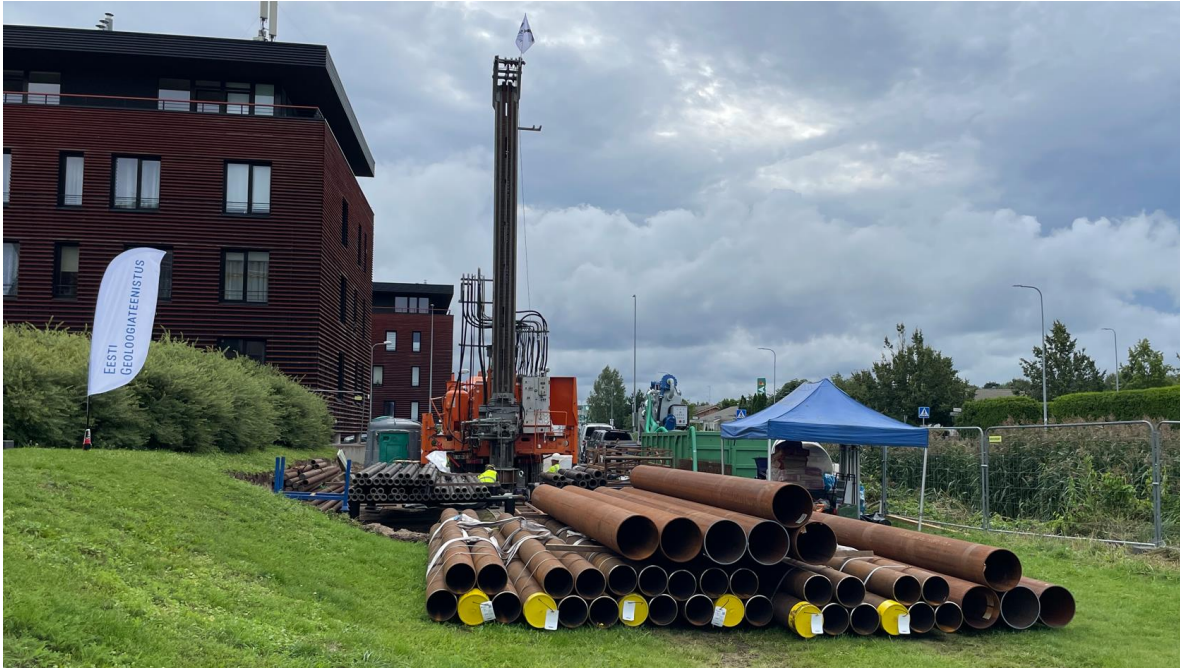
Joonis 19 Taludevahe 116 katsejaama ehitustööd. [26]
