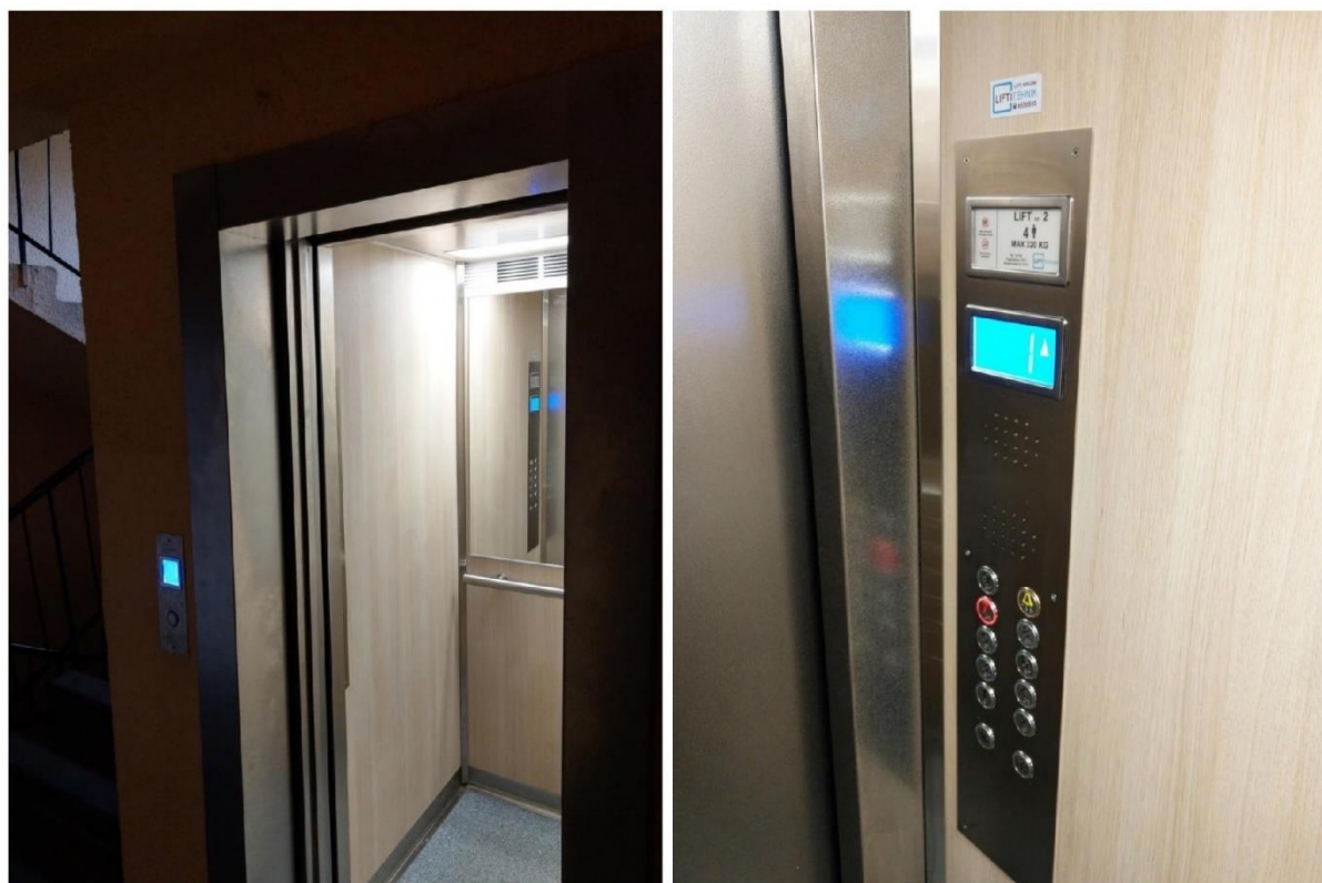
Joonis 1.5 Renoveeritud liftikabiini näide [7]
