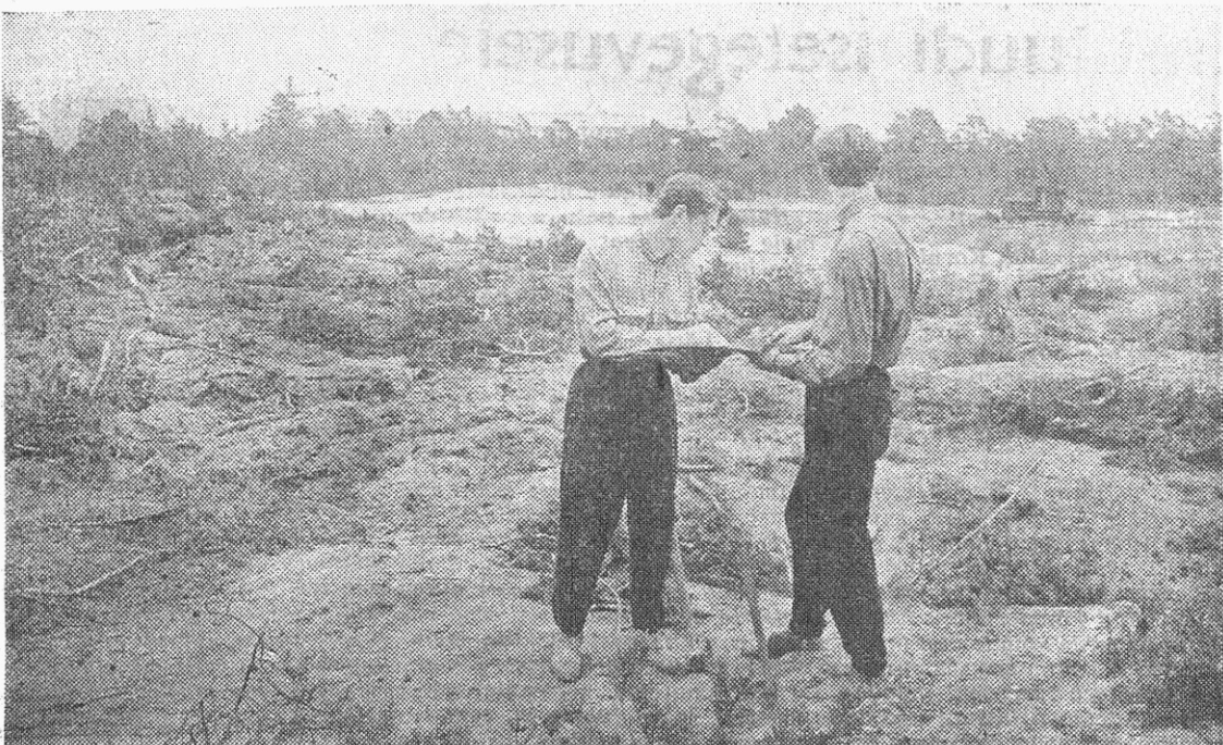
Pildil: Üliõpilased H. Vallimäe ja L. Enok (AT-44) staadionit nivelleerimas. Tagaplaanil uued õppekorpused.
