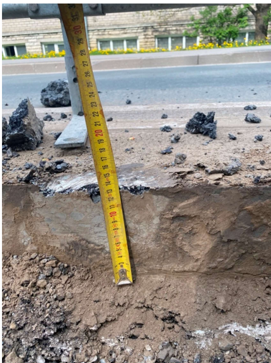
Joonis 3.7 Nõmme tee asfaldikatte lõige
