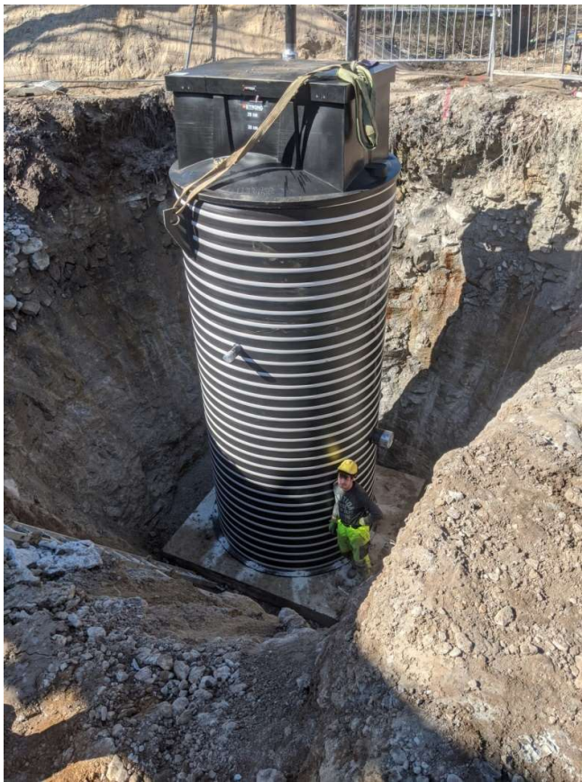
Joonis 4.7 Kanalisatsiooni pumpla paigaldus
