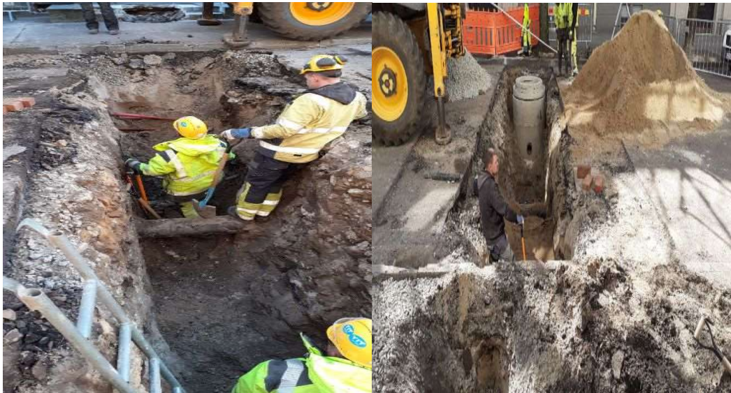
Joonis 3.10 Kentmanni tänaval uue kanaliliitumise kaevetööl tulid ootamatult ette vael kõrgusel olevad teised trassid. Uus kanalitoru kinnistule tuli tõsta plaanitust 1 m kõrgemale (vt parempoolne pilt).
