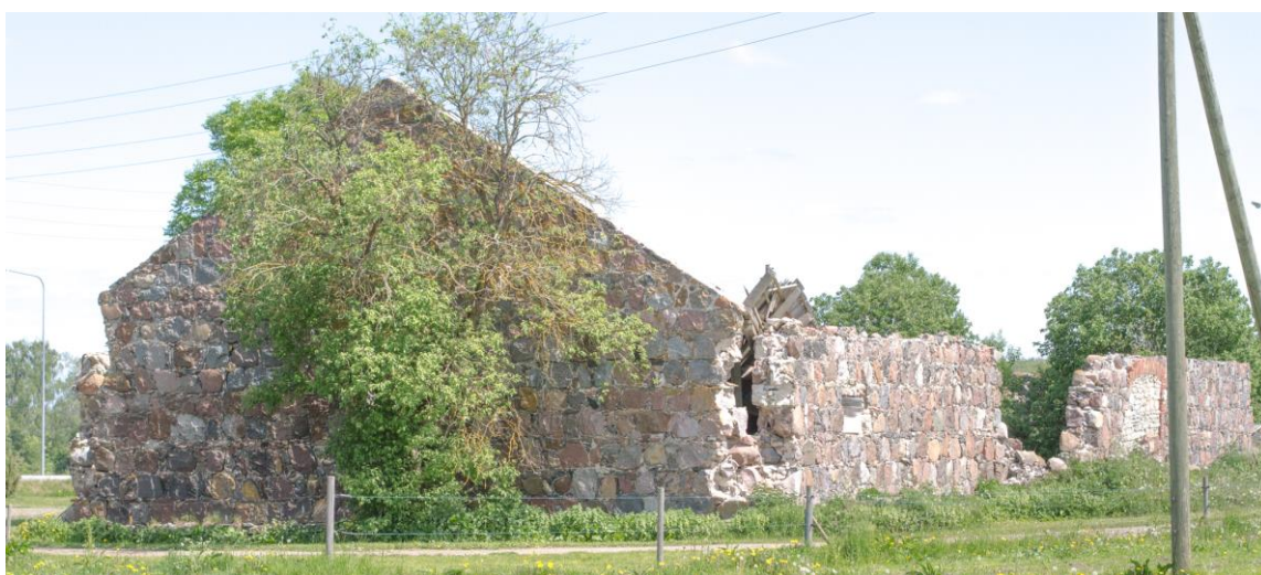
Foto 1. Vaade otsaseinale teljel A ja külgsainale teljel 1
