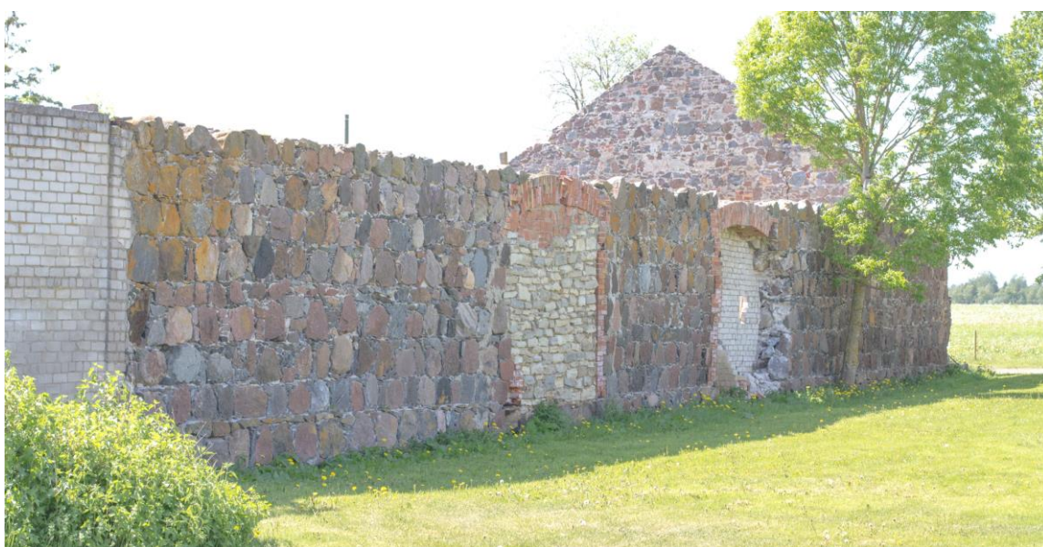
Foto 11. Hoone välisfassaad teljel 2
