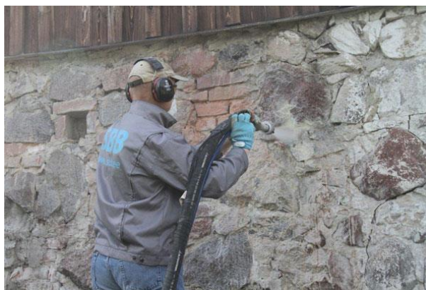
Foto 18. Kiviseina puhastamine soodapritsiiga [6]
