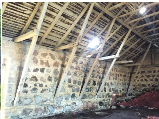
Foto 3. Sarnase hoone konstruktsioonilahendus
