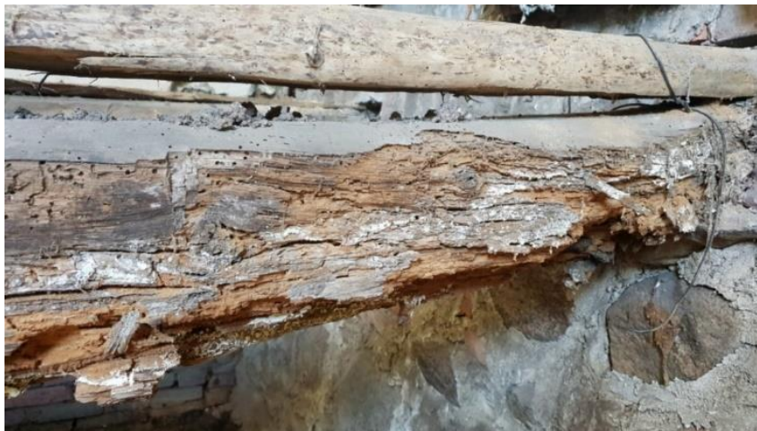
Joonis 6.14 Palgil olevad putuk- ja seenkahjustused (autori foto)
