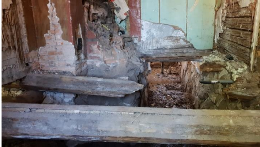
Joonis 6.15 Mädanenud palgid (autori foto)
