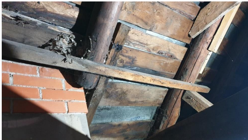
Joonis 6.19 Katkendlik sarikas asub korstna juures (autori foto)
