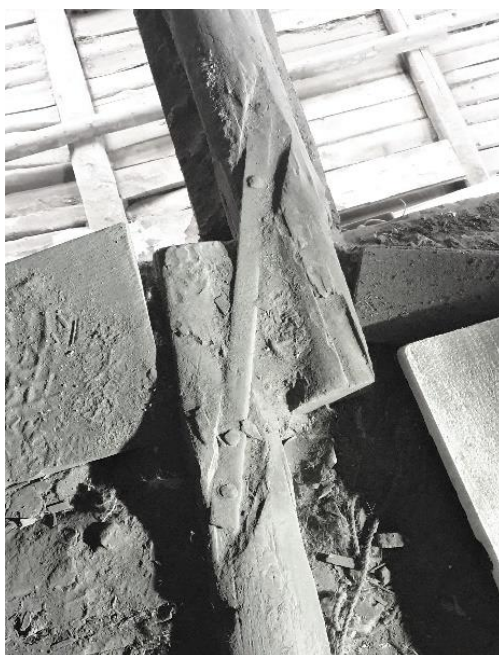
Joonis 6.18 Teise korruse ja pööningu vahelaetalade ühenduskoht, kasutades koba (autori foto)
