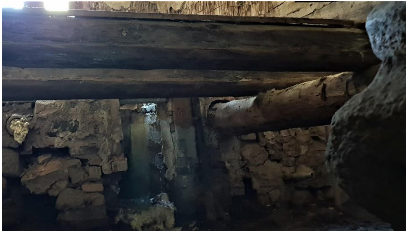
Joonis 6.16 Keldri vahelaetalasid toetav peatala (paremal) (autori foto)
