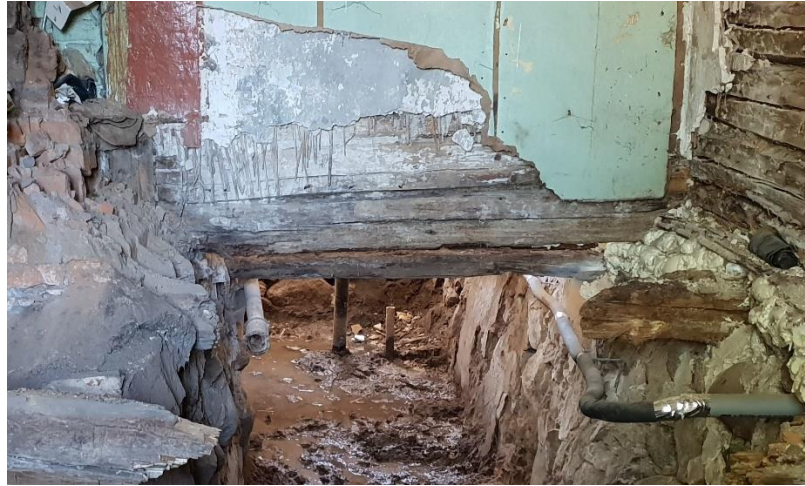
Joonis 6.10 Esimese korruse sisesein teljel C, telgede 4-6 vahel (autori foto)
