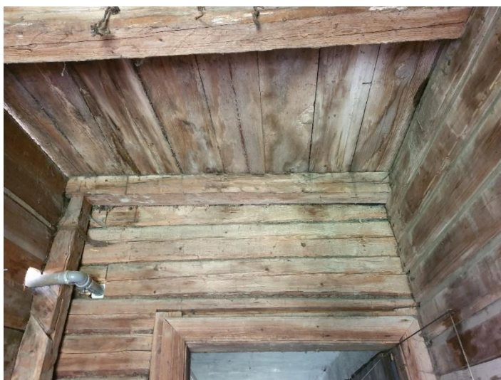
Joonis 5.3 Tuulekoja konstruktsioon ja ühenduskoht hoonega (autori foto)
