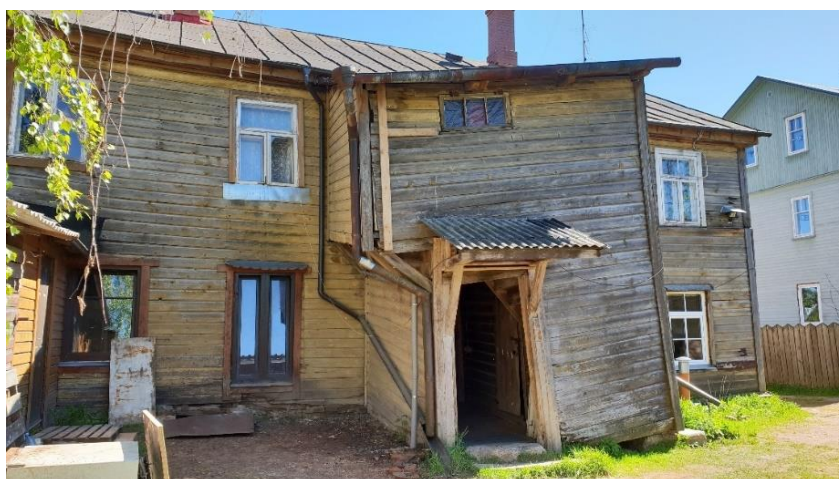
Joonis 6.21 Viltu vajunud tuulekoda (autori foto)
