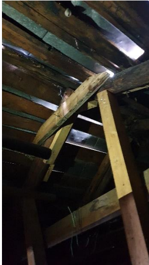
Joonis 6.20 Liitumiskohast toetatud sarikad ja penn (autori foto)
