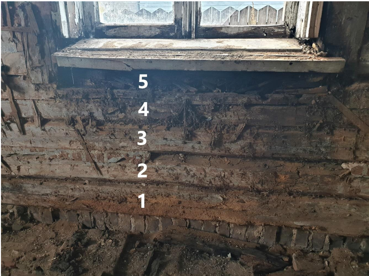
Joonis 6.3 Niiskusest põhjustatud hallituseente kahjustusega palgid hoone akna all seest poolt vaadatuna (autori foto)
