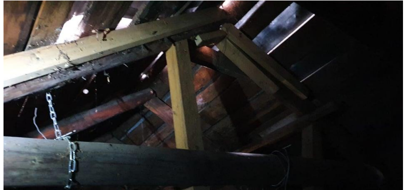
Joonis 6.20 Liitumiskohast toetatud sarikad ja penn (autori foto)
