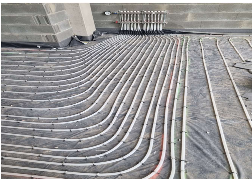
Foto 5.5 Korrekselt paigaldatud põrandakütte torustik
