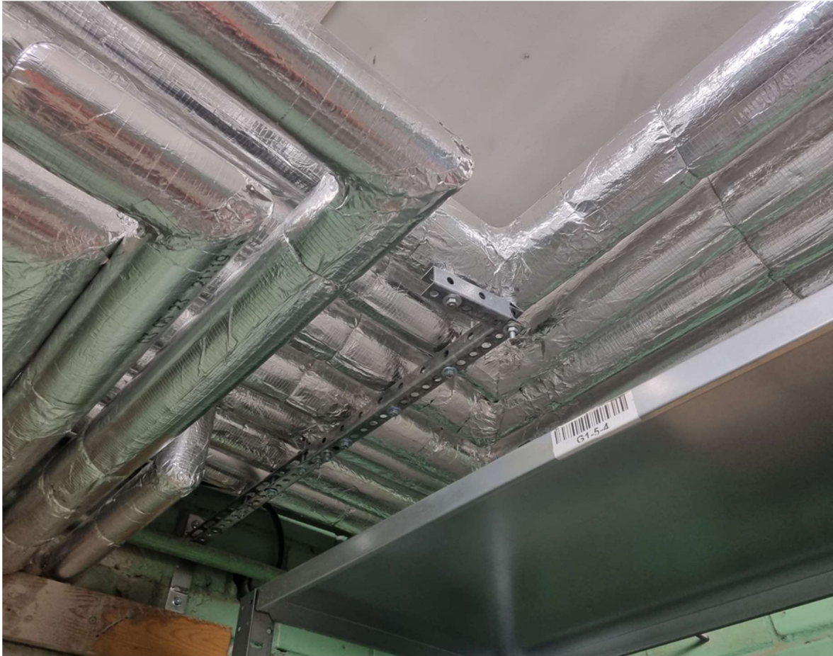
Foto 5.6 Ebakorrektselt paigaldatud konsooltugi
