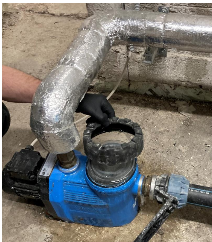
LISA 6 Hallvee süsteemi reoveepump koos filtriga
