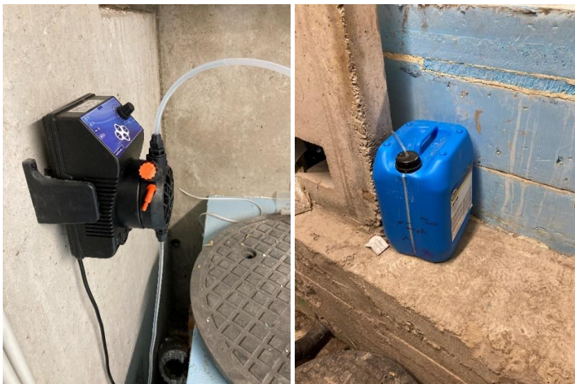
JOONIS 9 Bakteriaalse lisandi dosaator koos anumaga
