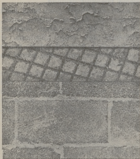
Joon. 91. Kiviseina katmine tsement-krohviga kahes kihis.
