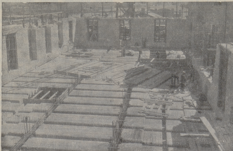
Joon. 71. Lae betoonimise eel asetatakse raudarmatuur; puukastid jäävad betooni alla.
