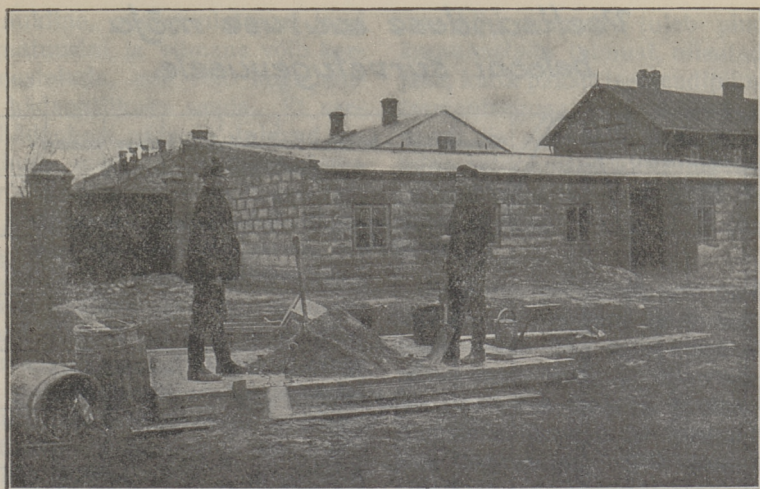
Joon. 29. Segu on valmis tehtud ja hunnikusse aetud.
