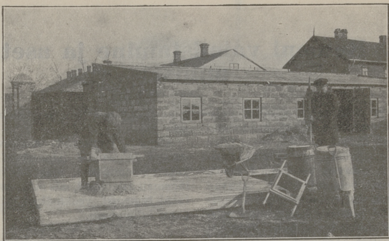
Joon. 24. Üks tööline valab lavale mõõdutäit liiva, teine avab tsemendi pütti.
