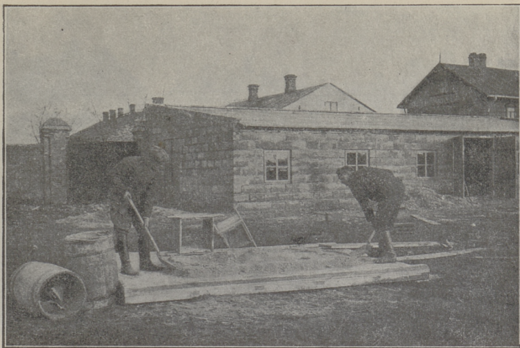
Joon. 25. Tsement on liiva pääle pandud ja töölised hakkavad segama. Enne looitakse hunniku servast liiva tsemendi pääle, et tuul seda laiali ei ajaks.
