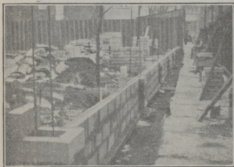
Joon. 87. Aiaplangu ehitamine tsementkividest.
