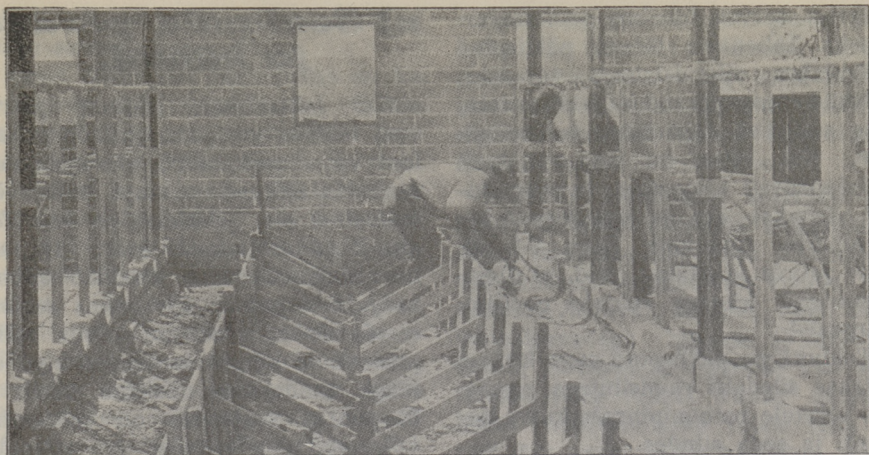
Joon. 95. Toiduküna betoonimine.
