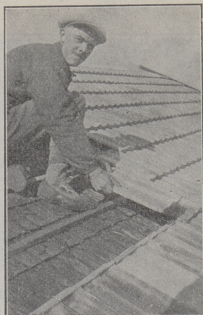
Joon. 79. Katuse katmine tsementkividega vana pilbaskatuse pääle.
