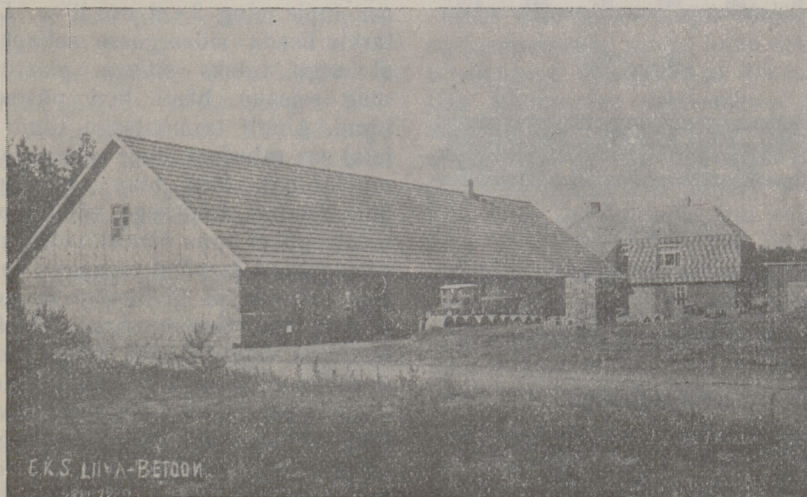
Joon. 49. Tööstuse ruum, ehitatud betoonkividest, tsementkividest katusega.
