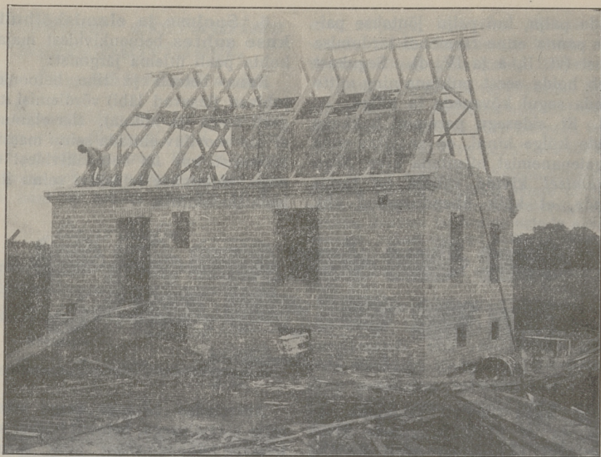
Joon. 52. Nopsa-süsteemi elumaja ehitamisel.
