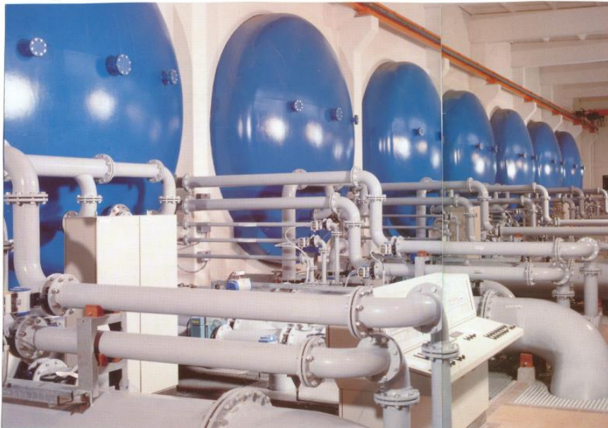
Joonis 9.17. Filtrisaal horisontaalsete survefiltritega
