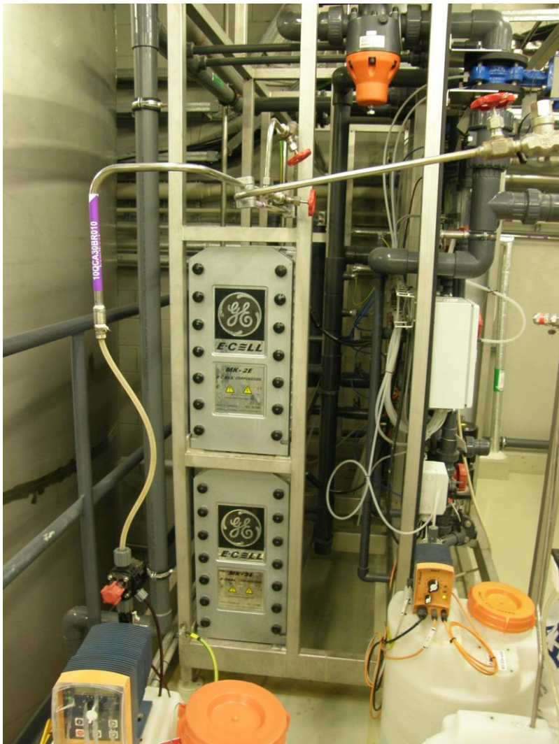
Joonis 16.9. EDI seade Tallinna Vao Elektri jaamas
