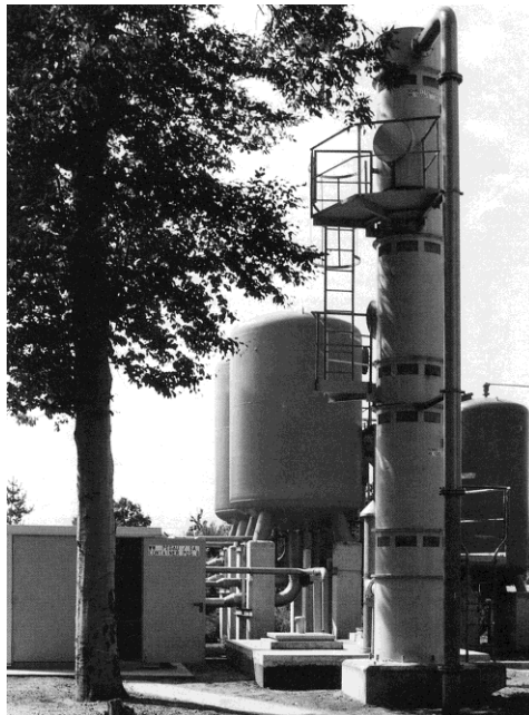
Joonis 11.1. Gradiiriga konteinerpuhasti Fe ja Mn ärastamiseks tootlikkusega 60 m 3 /h.
