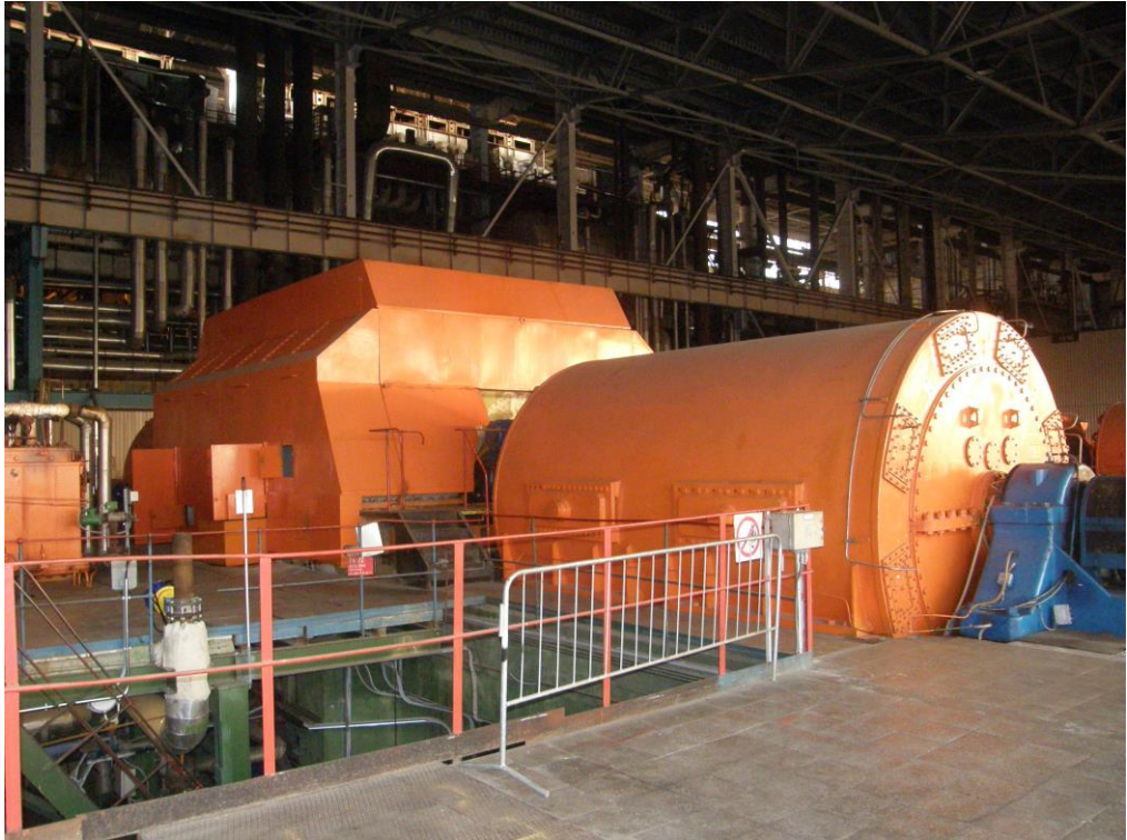
Joonis 17.6. Auruturbiin ja elektrigeneraator Iru Elektriijaamas
