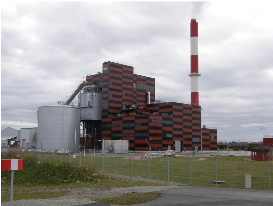
Joonis 17.7. Väo Elektriijaam
