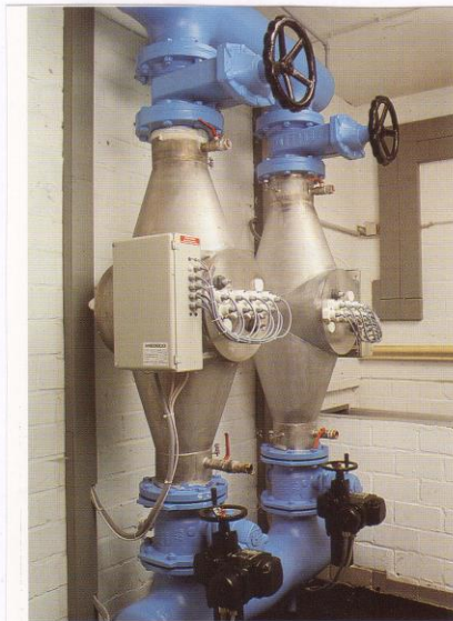
Abb. 1: Trinkwasser-Entkeimung in einem Wasserwerk, 2 x 230 m 3 /h, Typ 54-K48
