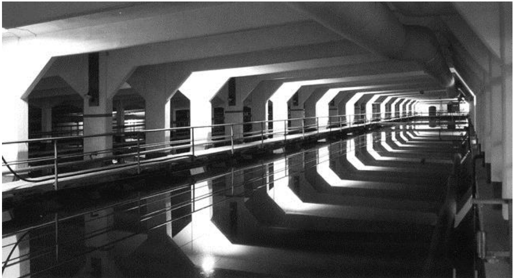
Joonis 8.7. Horisontaalsetitid Helsingi Vanhakaupunki veetöötusjaamas
