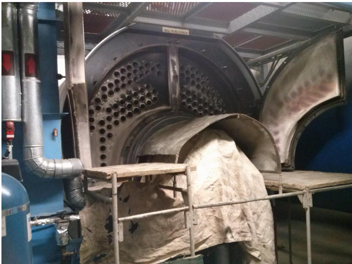
Joonis 2.2 DANSTOKER katel võimsusega 3,5 MW.
