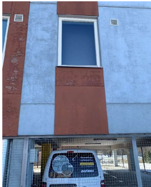
Joonis 2.1.7.1-2: Tuulduv tarind akna all
