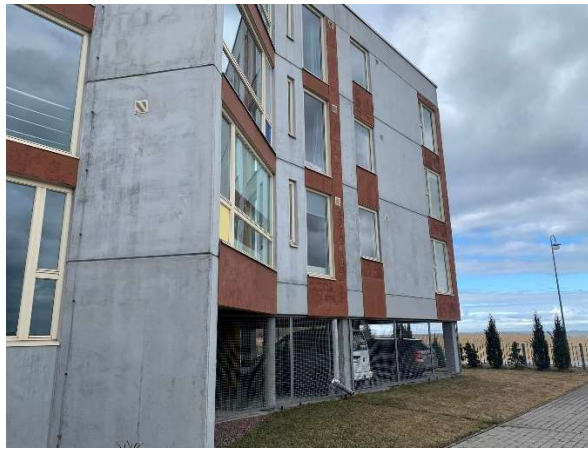
Joonis 2.1.7.1-1: Vineerplaadid fassaadil
