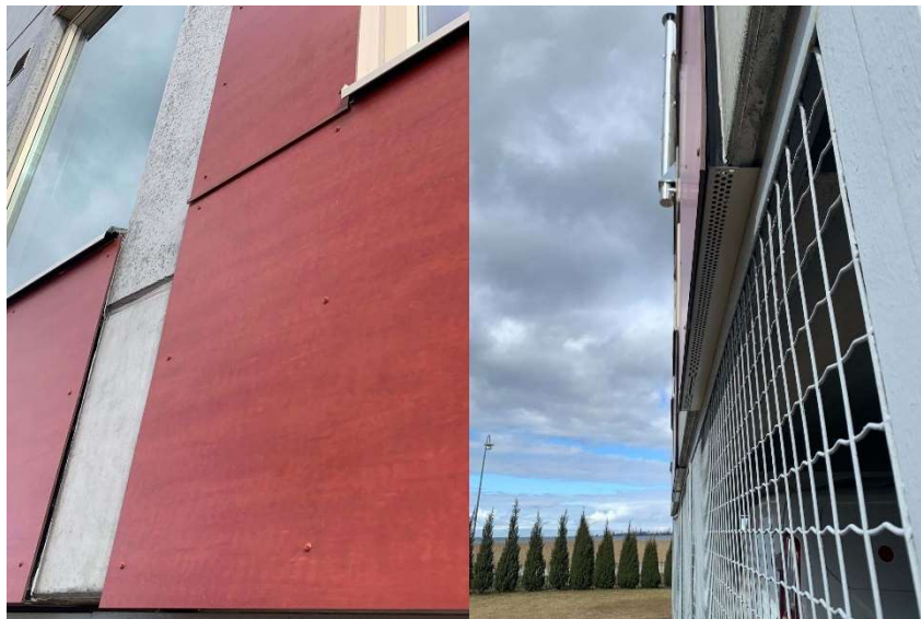
Joonis 2.1.7.1-8: Naabermaja uued fassaadiplaadid ja tuulutusrestid
