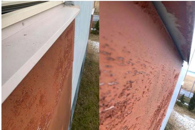
Joonis 2.1.7.1-6: Aknaplekiga suletud tuulutusvahe
