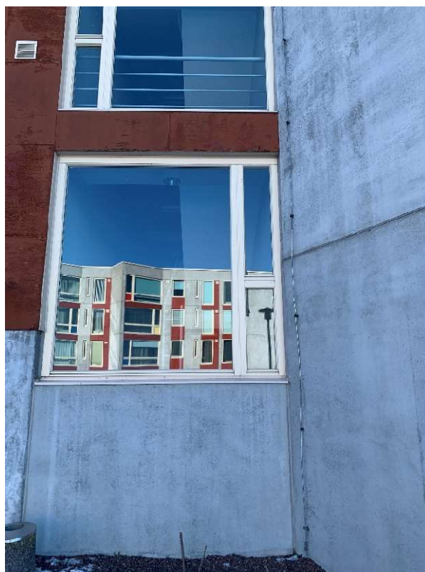
Joonis 2.1.7.1-4: Kahe trepikoja akna vaheline tuulutatav tarind
