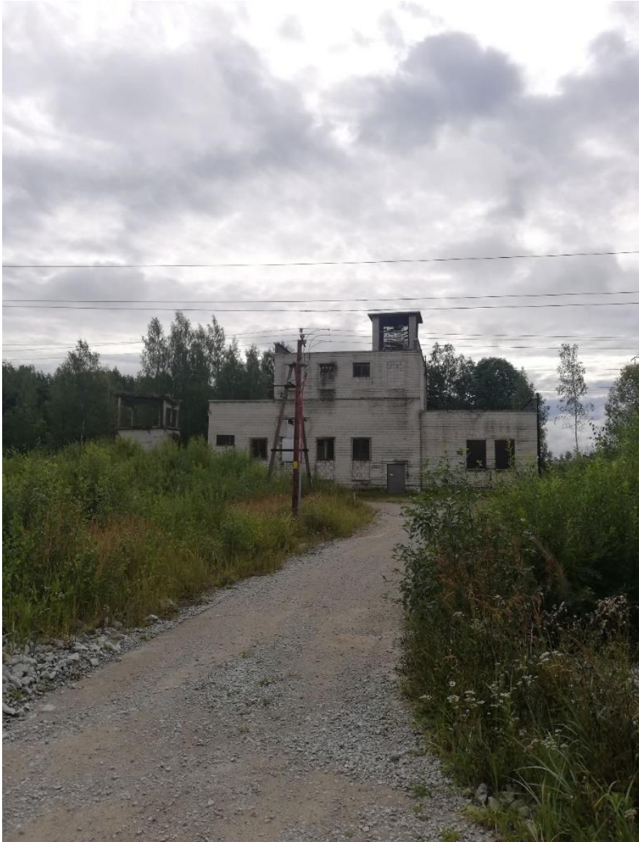
Joonis 4 Tuulutusšurfi hoone nr. 3 (N 59.204437, E 27.412794).
