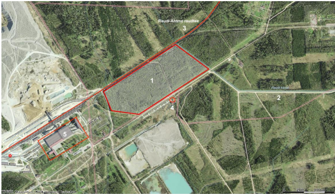
Joonis 2 Alustarindi maapealne ala objektid: 5- Alutaguse alajaam; 4- tuulutussurf; 3-raudtee; 2- Raudi kanal; 1- päikeseelektrijaam (aerofoto Maa-ameti Geoportaalist).
