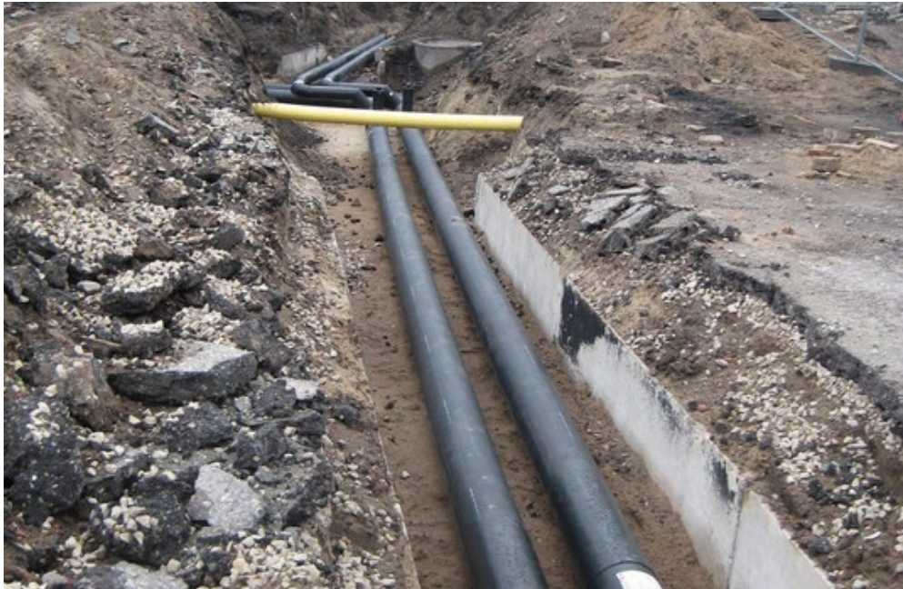
Joonis 5.18. Kaugküttestorustiku renoveerimine. Vanasse „künasse“ on paigaldatud uued torud, küna lagi on eemaldatud ja kogu kaevis täidetakse pinnasega. Allikas: SW Energia koduleht.
