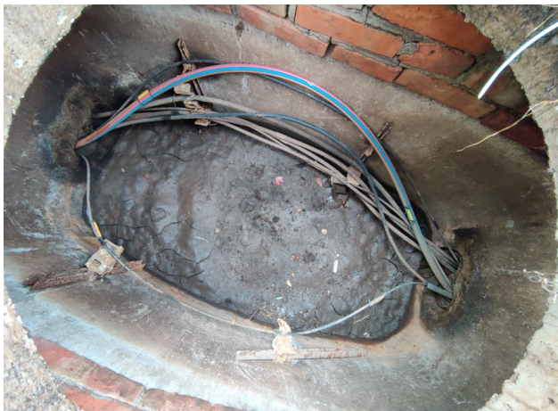
Joonis 5.25. Tüüpilise pikliku konfiguratsiooniga sidekaev sidekanalisatsiooni kahe toruga paketist koosneval torustikul. Torude paketid võivad olla kuni 20 toruga ja sisendeid võib kaevus olla mistahes nurga alt. Allikas: Inseneribüroo REIB OÜ fotokogu.
