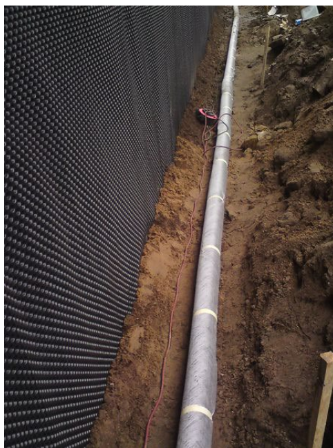
Joonis 5.6. Vundamendi drenaaz, kaitstud geotekstiiliga. 21
