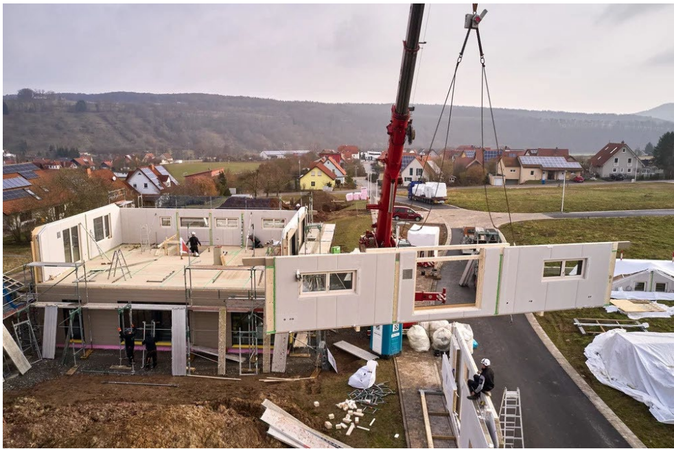
Joonis 13.1. Suurpaneelhoone montaaž 49 .
