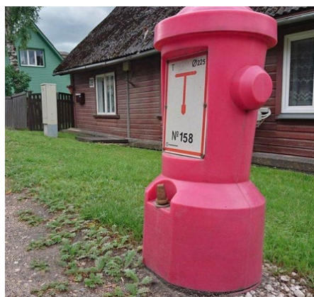
Joonis 5.4. Veetorustiku sulgeseade kaevus (peatorustik mattunud) ja maapealne hüdrant. Allikas: Inseneribüroo REIB OÜ fotokogu.
