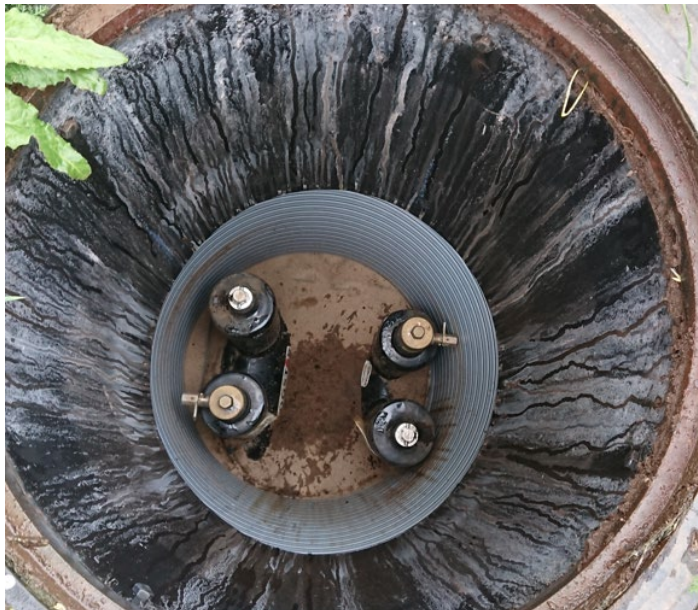
Joonis 5.17. Tänapäevane kaugküttetorustiku kaev. Näha on ainult sulgeseadmed koos õhueraldajatega. Allikas: Inseneribüroo REIB OÜ fotokogu.
