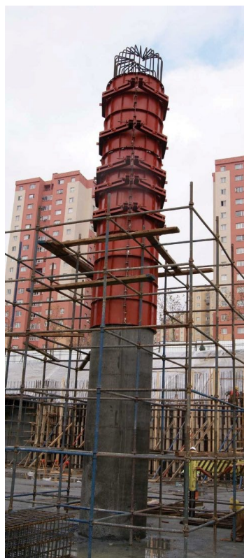
Joonis 12.8. Näiteid raketistest: ümarposti 46 (vasakul), seinte 47 (paremal üleval) ning vahelae talade ja vahelae 48 (paremal all) raketised.
