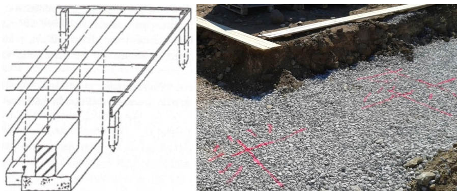
Joonis 6.7. Vundamendi rajamine märktara telje- ja servatraatidelt ripputatud ripploodide abil (vasakul; Salmenperä, 1997) ning vundamendi nurkade ja suundade märkimine markervärviga (paremal).
