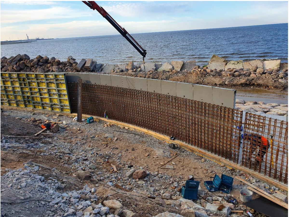
Foto 1.2 Radiaal sein, raketise paigaldamine Doka 90x270
