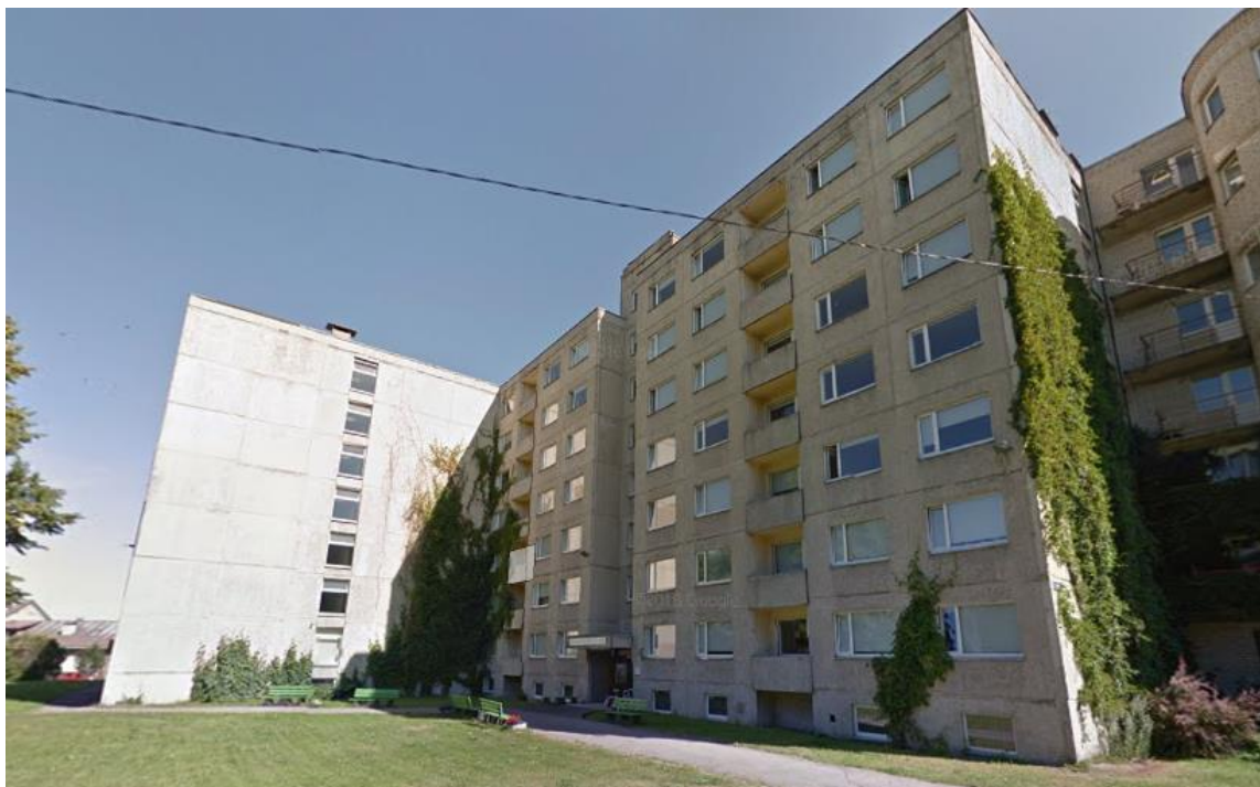
Joonis 1.2 Üliõpilaselamu Karu 17 [2]
