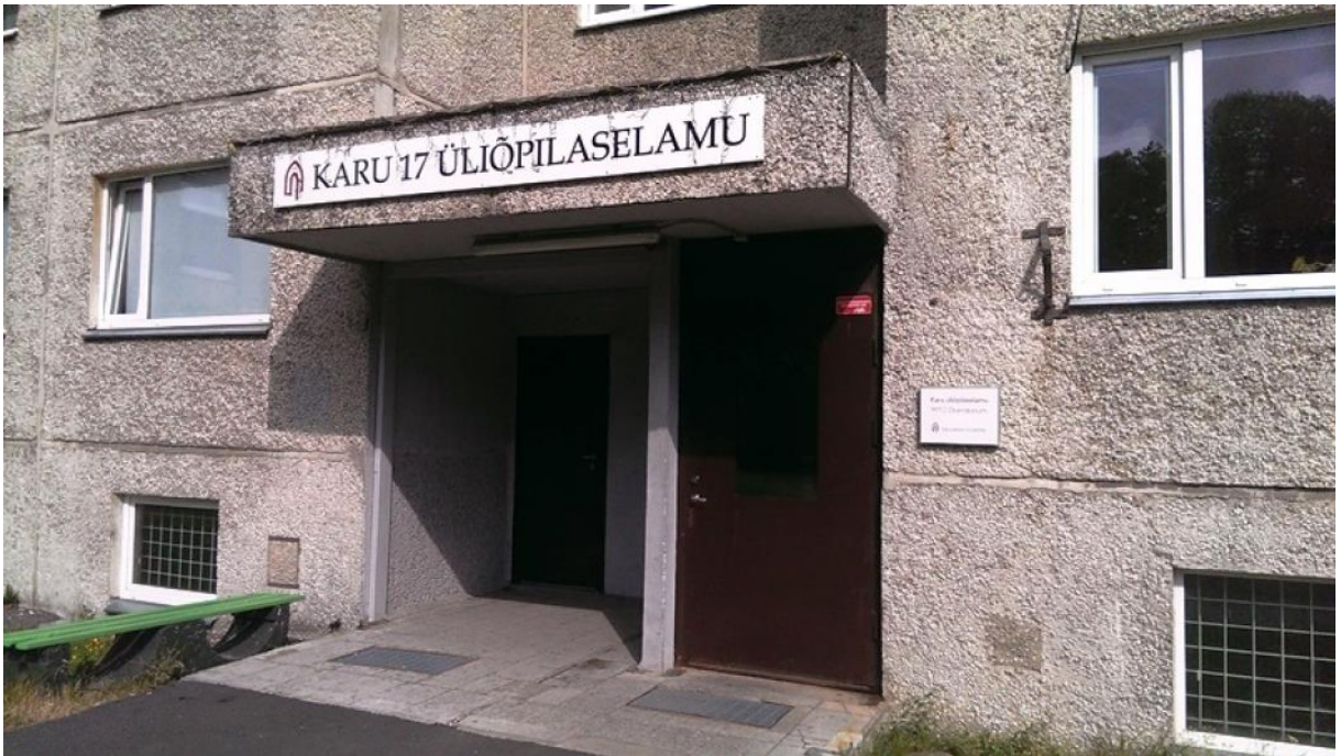
Joonis 1.3 Üliõpilaselamu Karu 17 [2]
