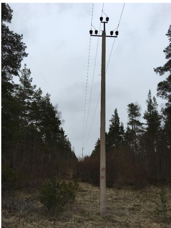
Joonis 52. Suuremõisa lubjakivimaardlat piirav elektri ülekandeliinide koridor, mis seab kaevandatavale osale piirangud. Foto: Erakogu, 29.04.2017 kell 11.42
