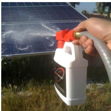
Joonis 3.5.8.1. Päikesepaneeli puhastamine tolmust (Autor: tundmatu).
