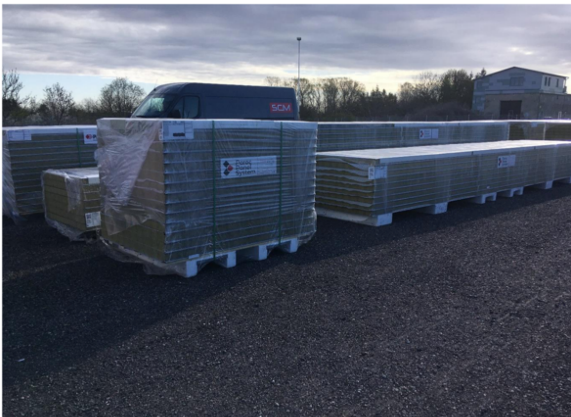
Joonis 1.2 Näide ehitusobjekti laoplatsilt, kus sändvitšpaneelides olev kivivill on avatud keskkonnale ning on märgumise oht (Kalamees)
