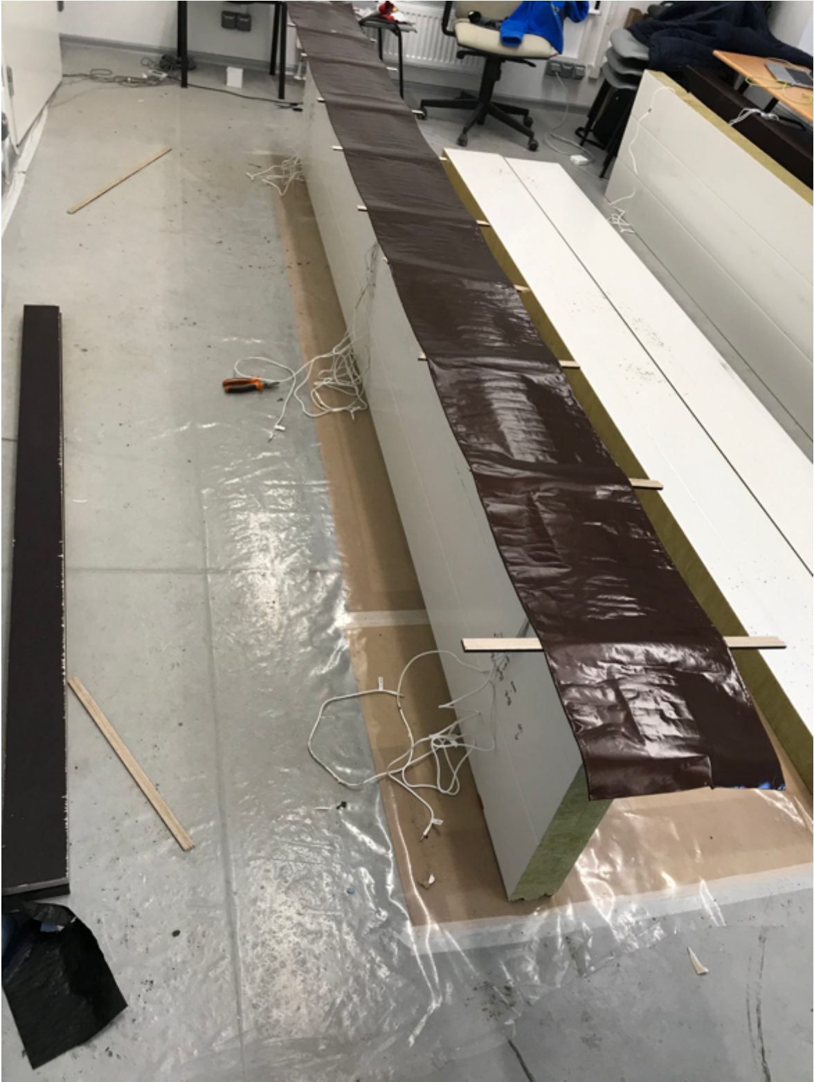
Joonis 2.12 Bituumen-alumiinium teibi kleepimine vineeri peale ja paneeli külgedele.
