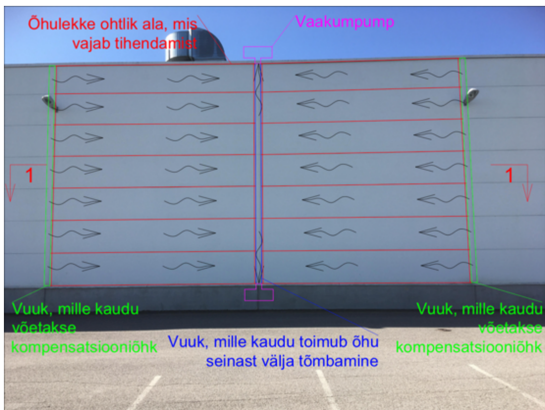
Joonis 3.42 Ventileeritava seina vaade. Nooltega on tähistatud õhu liikumise suund paneelis kompensatsiooniõhu vuugist ventileeritava vuugini
