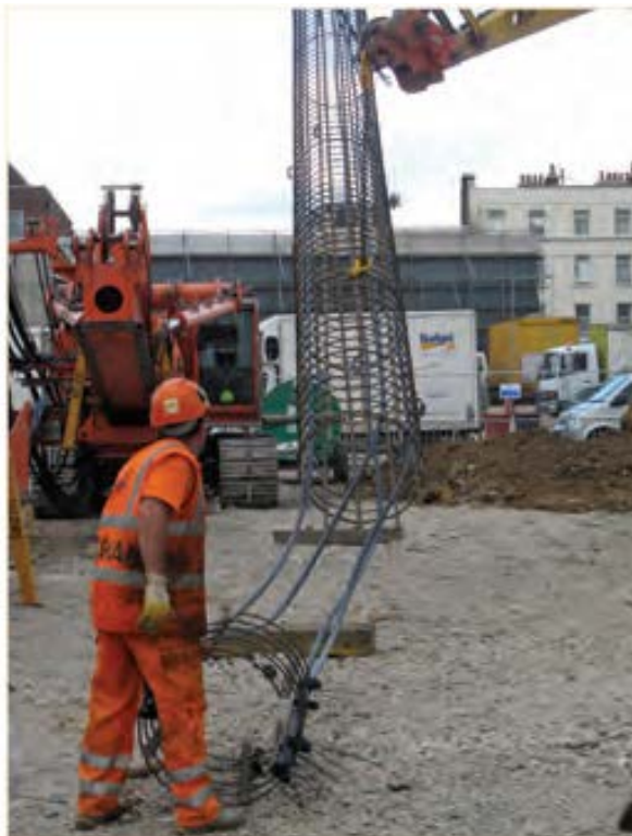
Joonis 15 Energiavaia armatuuri installatsioon [14]
