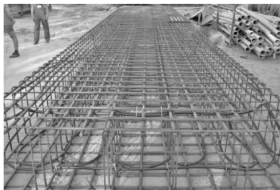
Joonis 12 Soojusjuhtivustorud ühendatuna röstvärki [5]
