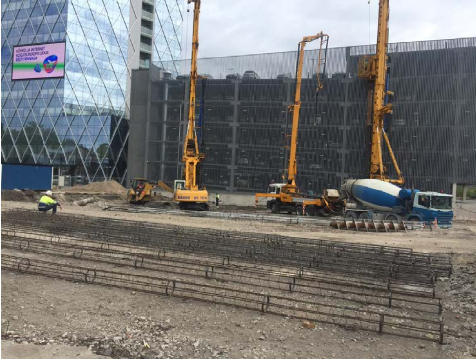
Joonis 29 Maas asetsevad betoonarmatuurid ning taamal spetsiaalsed masinad millega neid puurauku tõsta [27]
