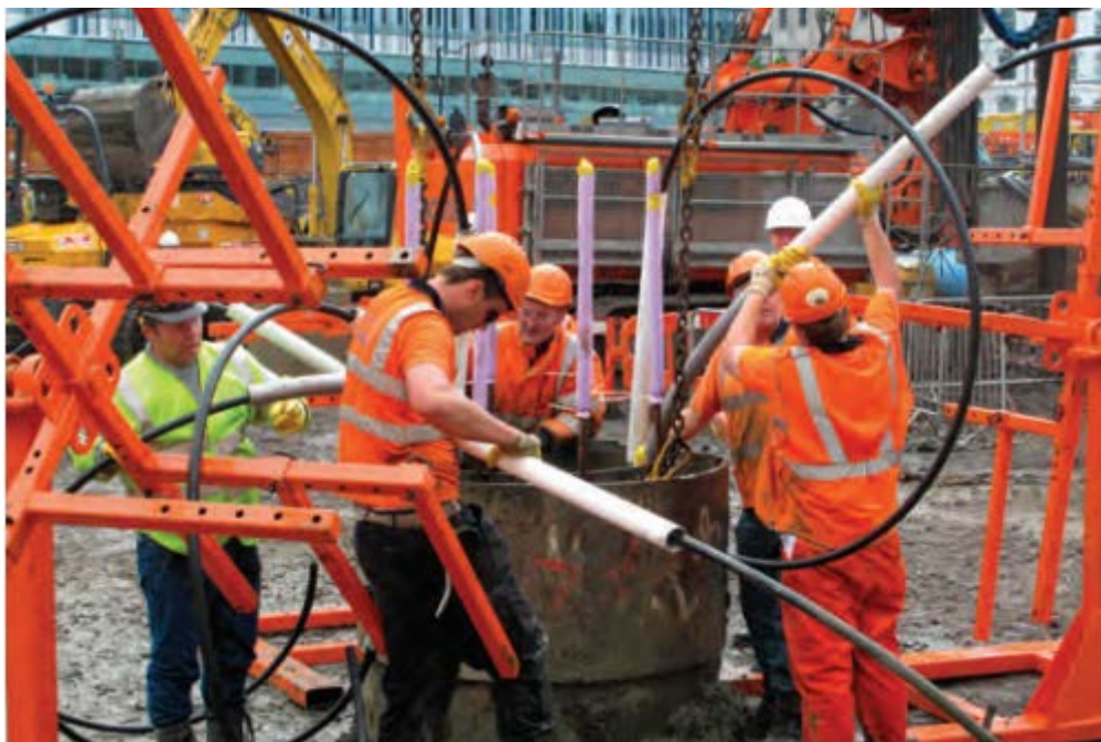
Joonis 19 Soojusjuhtivustorude otste katmine plastikvahaga [14]
