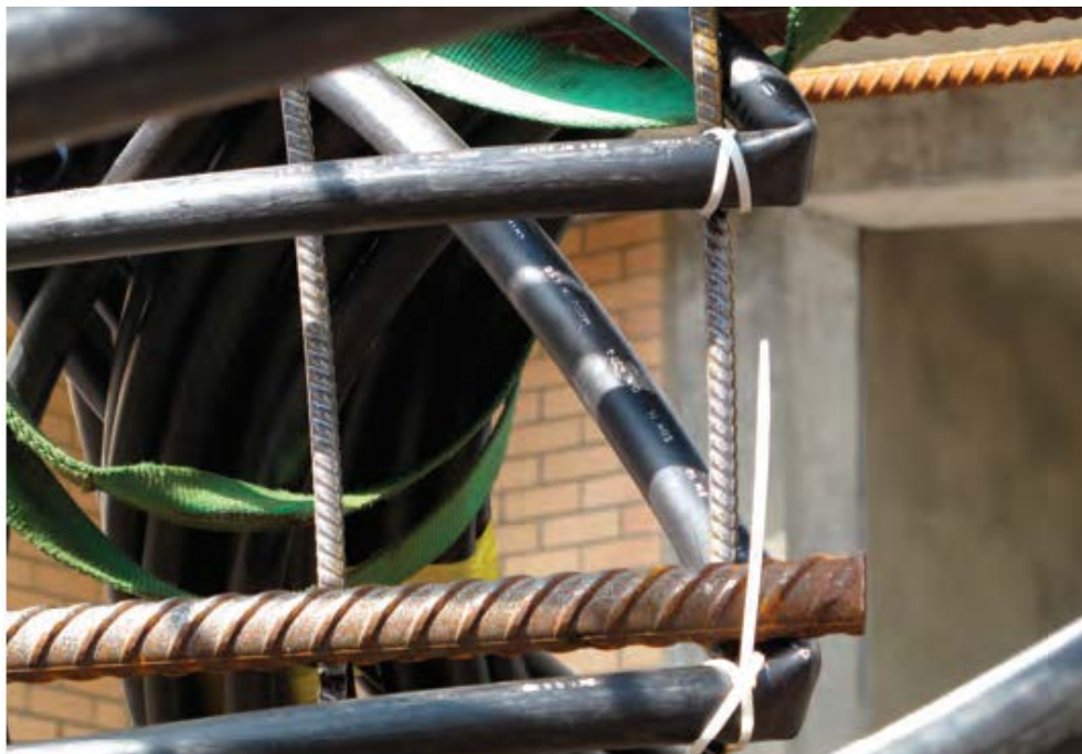
Joonis 13 Ära painutatud soojusvahetustoru [14]
