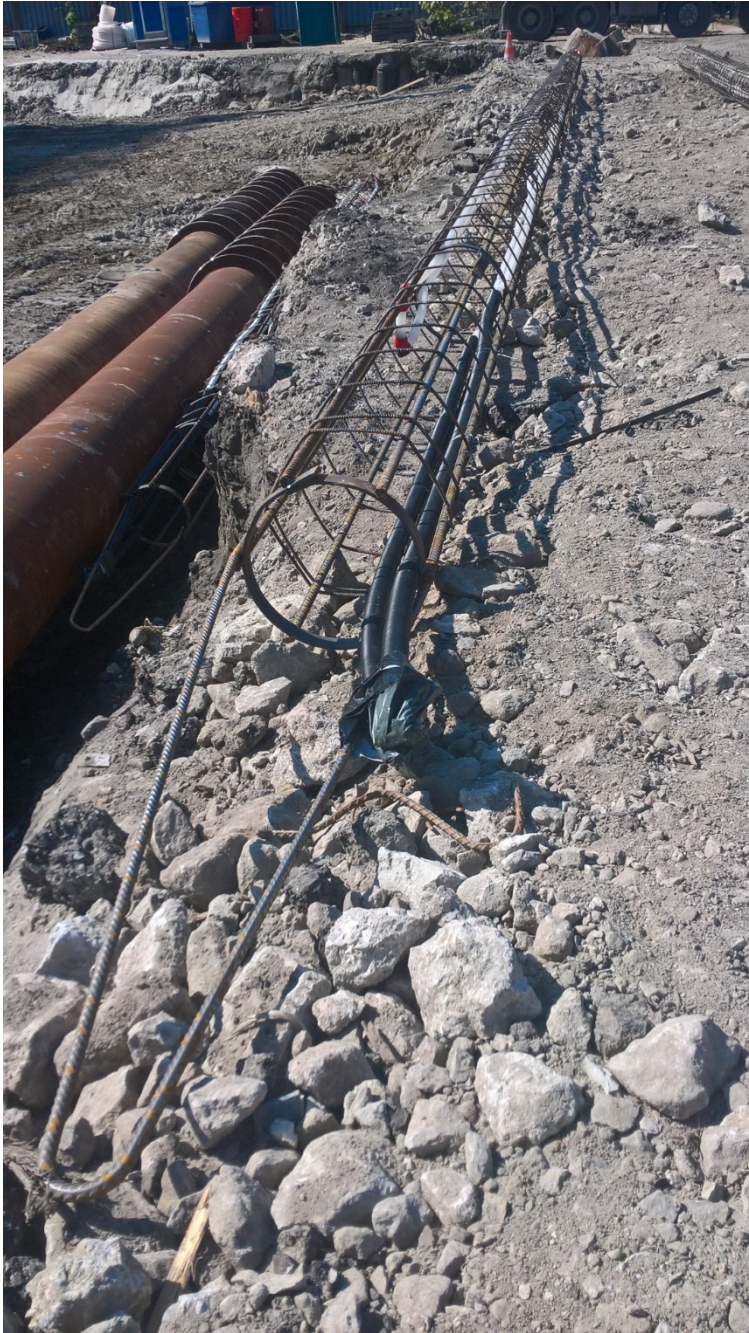
Joonis 30 Betoonarmatuur, kuhu sisse on asetatud soojusülekangetoru [27]
