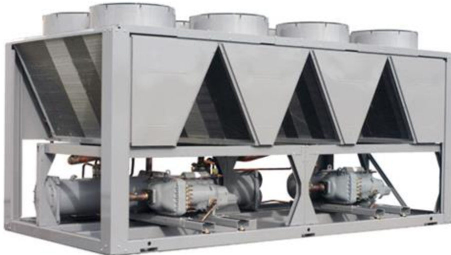
Joon. 1.5 Aurukompressiooniga chiller [3]
