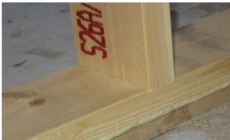
Joonis 4.16 Karkassipostide T- seotis. Foto: M. Riistop
