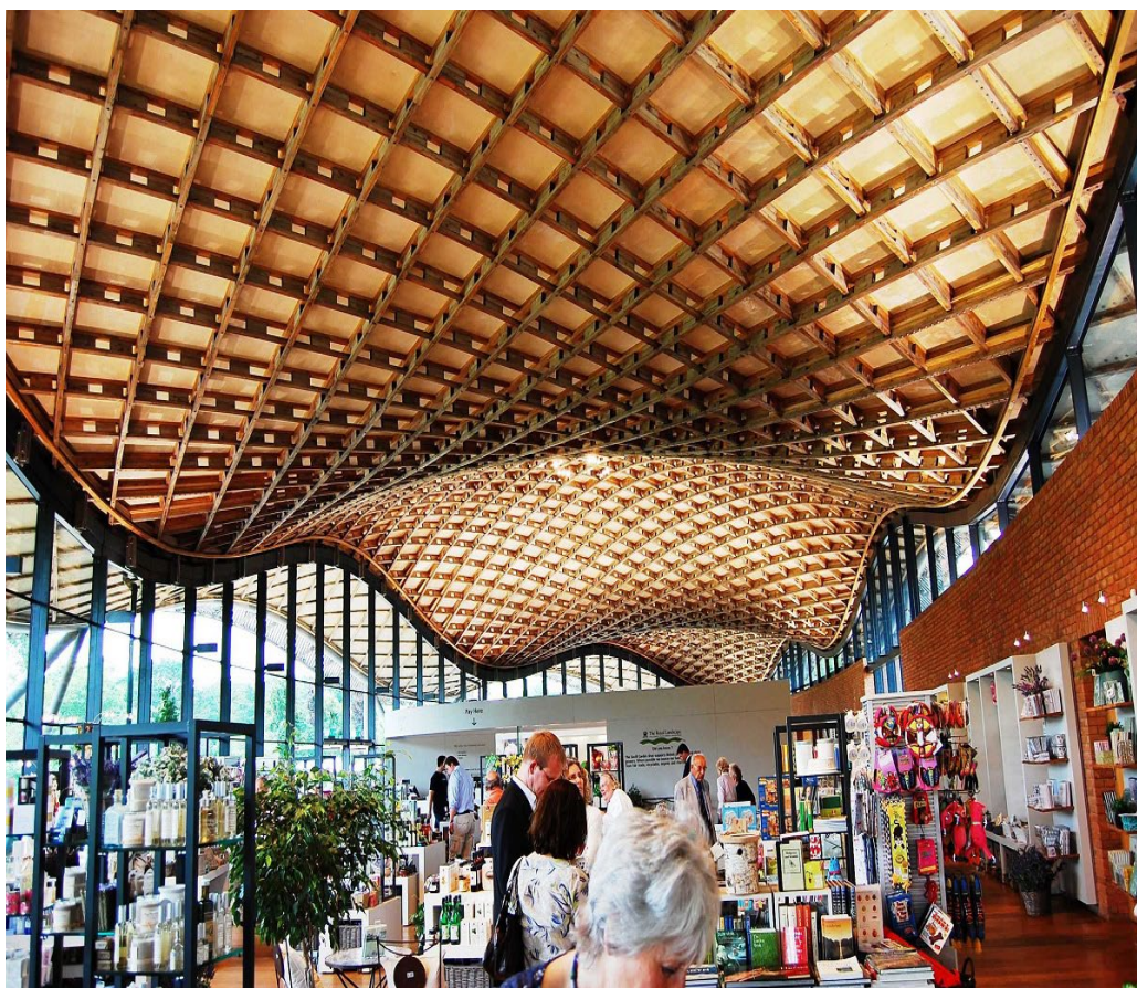
Joonis 5.34 Saville Gardeni kergtaladest võrekoorikust katus. Foto: M. Riistop
