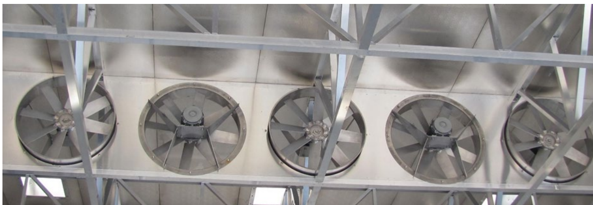
Joonis 3.6. Telgventilaatorid kuivati ülemises tsirkulatsioonikanalis. Allikas: Termolegno S.R.L.
