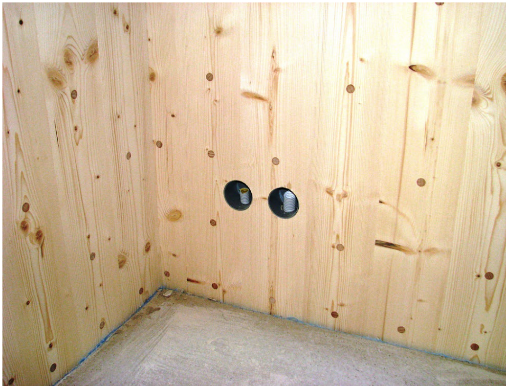
Joonis 5.28 Tüüblitega ühendatud ristkihtliimpuit. Foto: M. Riistop
