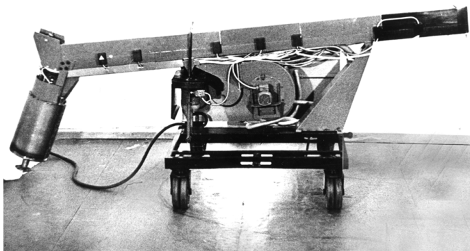
Teisaldatav sulametalli MHD-ajam.
