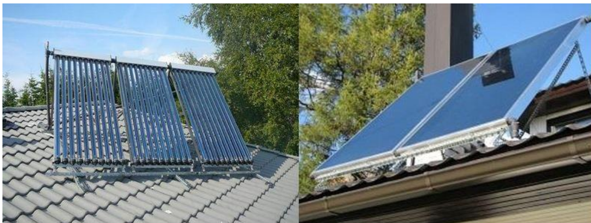
Joonis 5.3.2 Vaakumtoru kollektorid vasakul ning lamekollektorid paremal [33]
