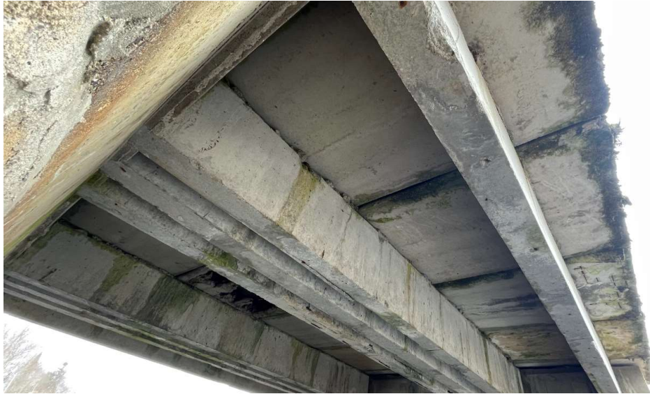
Joonis 5.10 Selli silla tekiplaat ja talad
