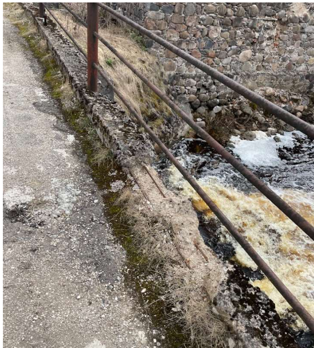
Joonis 5.11 Sae tammi 1. osa servapruss
