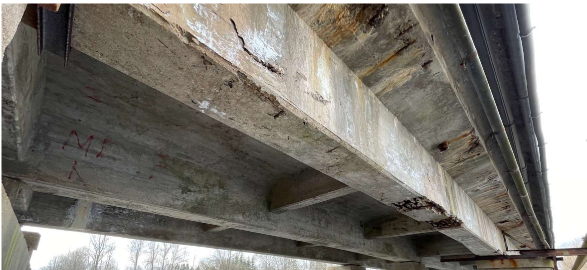
Joonis 5.14 Pedja silla talad, tekiplaati ja joatorud/tilktorud
