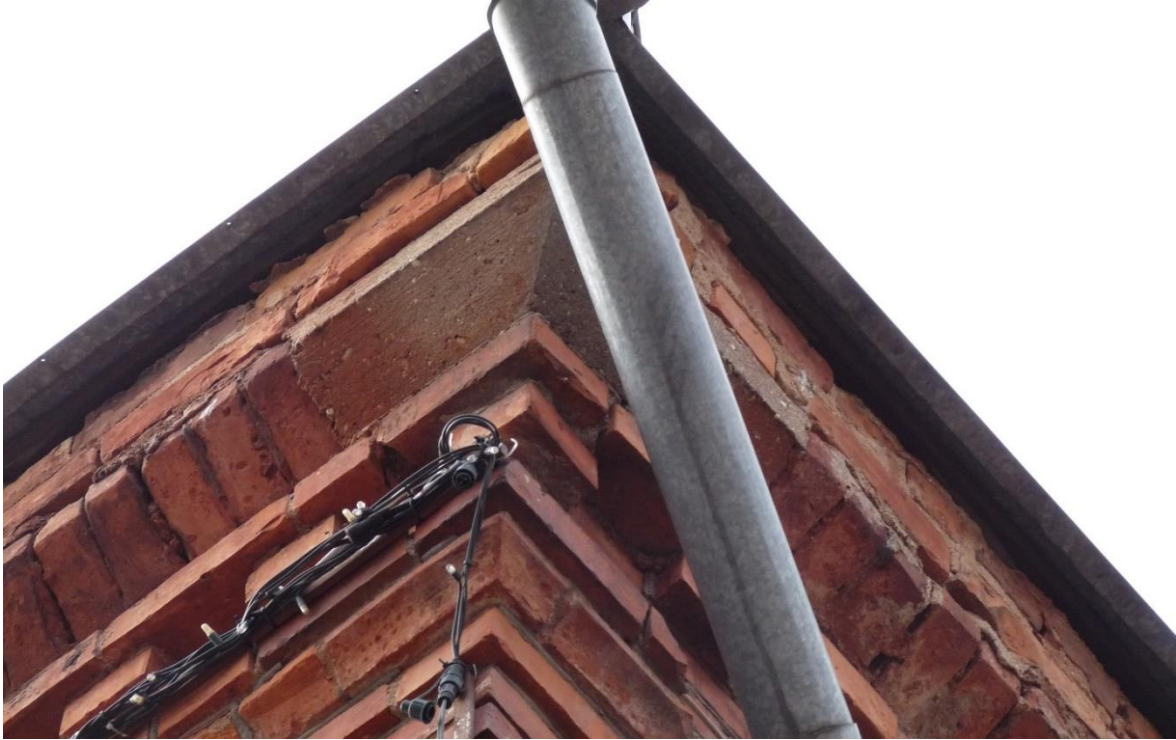
Joonis 38 – Betoonplokiga asendatud nurk – Kaaret, T. 10.04.2015
