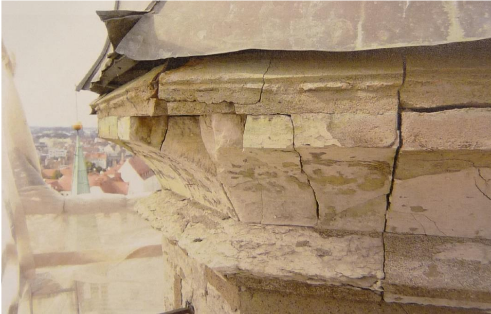
Joonis 53 – Plekk ei kaitse karniisi piisavalt – Uuetalu, 2009, n9.5524B
