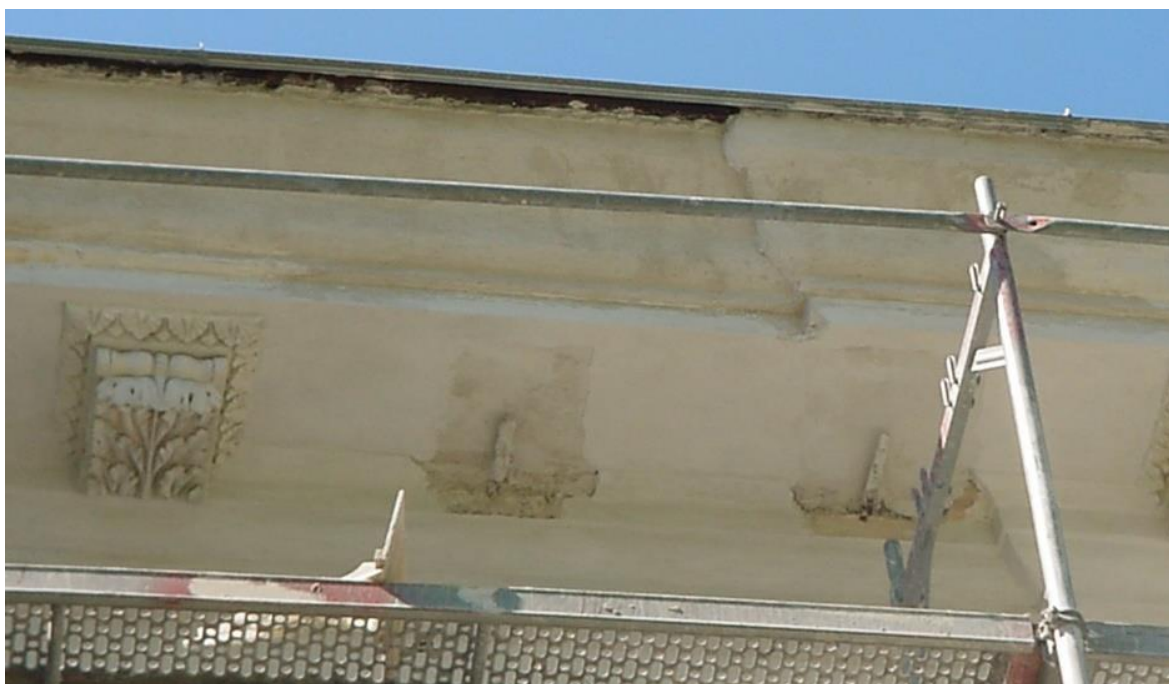
Joonis 72 – 2002, karniisi ja pleki kokkukrohvimine – Vali, J. fotokogu
