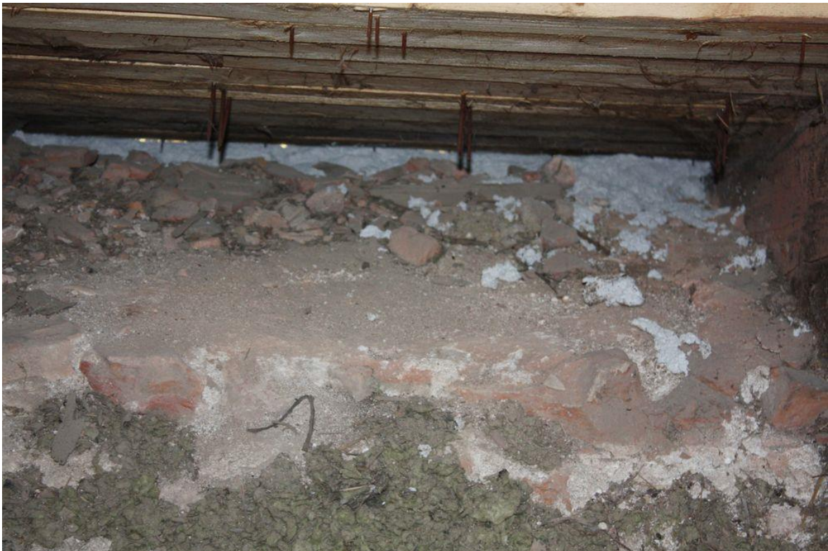
Joonis 65 – Tuulutusvahe on krohviseguga täidetud – Vali, J. fotokogu
