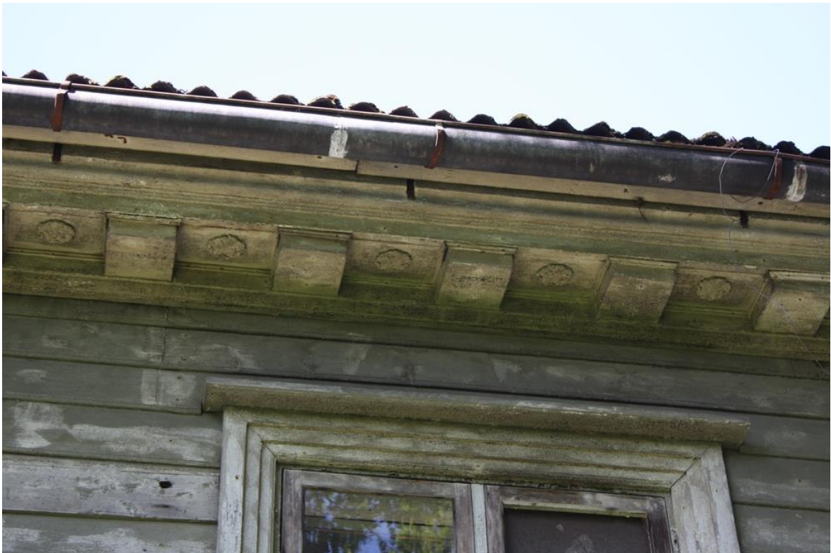
Joonis 81 – Puidust kassetide ja rosettidega karniis Einmanni mõisahooneel – Vali, J. fotokogu
