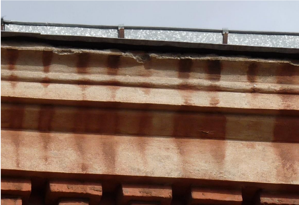
Joonis 32 – Veejäljed ja pudenenud karniisiäär – Kaaret, T. 10.04.2015
