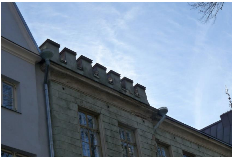
Joonis 6 – Cavetto ja sakseline müürilõpetus historitsistliku fassaadikujundusega hoonel Pikk 52, Tallinn – Kaaret, T. 17.03.2015
