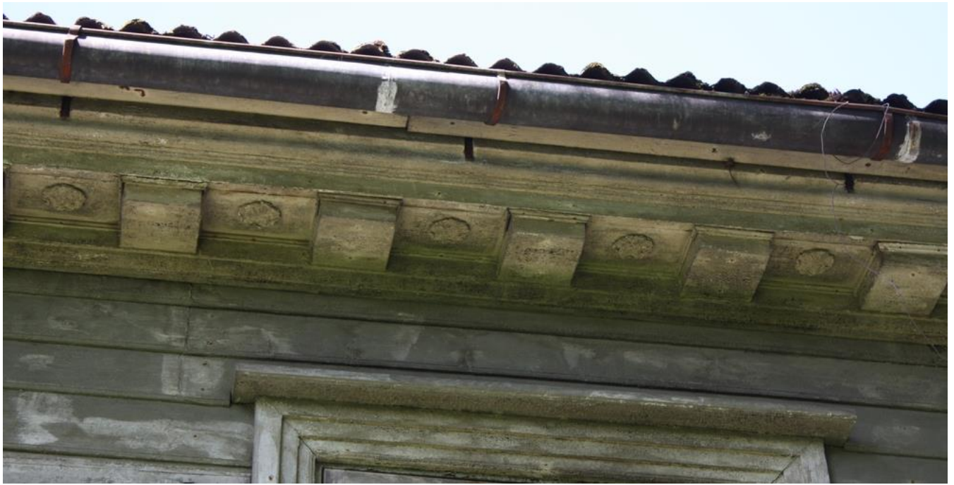
Foto 3 – Puidust kassettide ja rosettidega karniis Einmanni mõisahooneel – Vali, J. fotokogu
