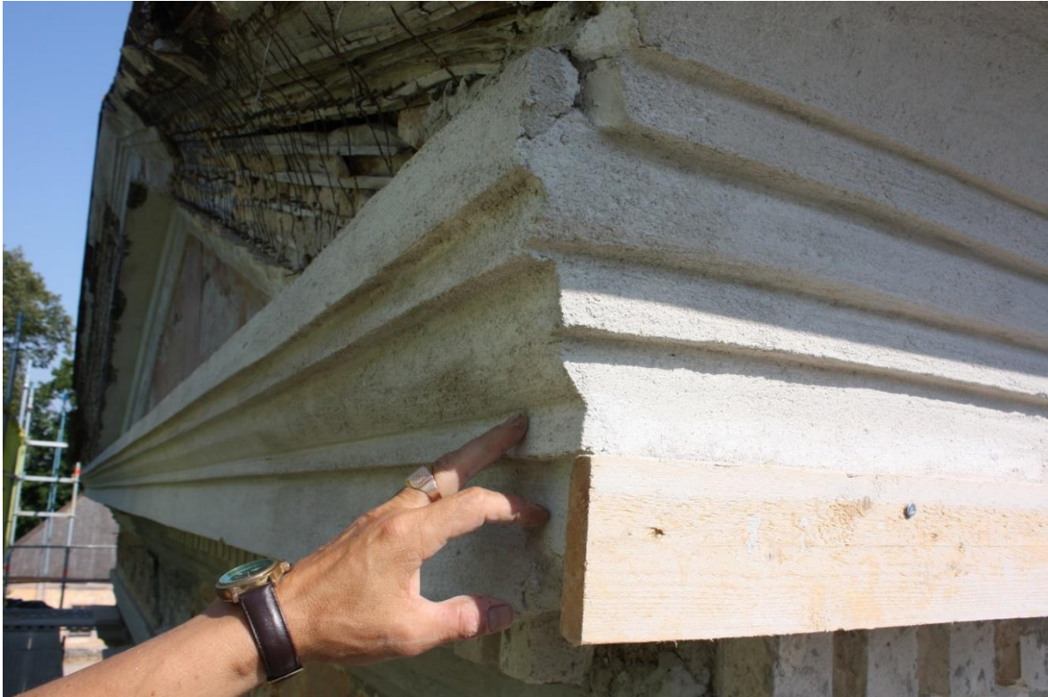
Joonis 64 – Karniisiprofiilid ei ühti nurgas – Vali, J. fotokogu
