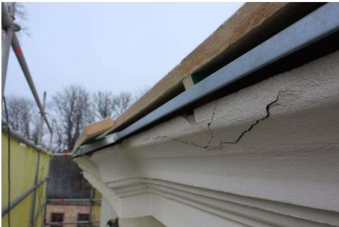
Joonis 62 – Räästatõstja liikumine lõhub vastrestaureeritud karniisikrohvi – Vali, J. fotokogu
