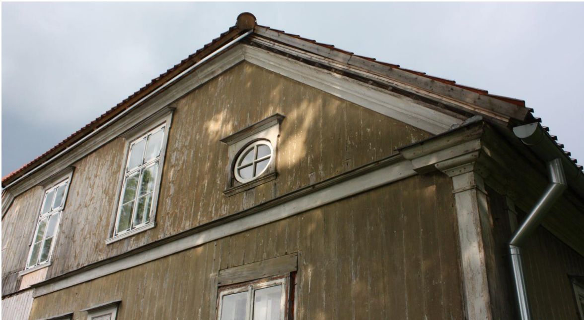
Joonis 87 – Tõusnud räästajoon – Vali, J. fotokogu
