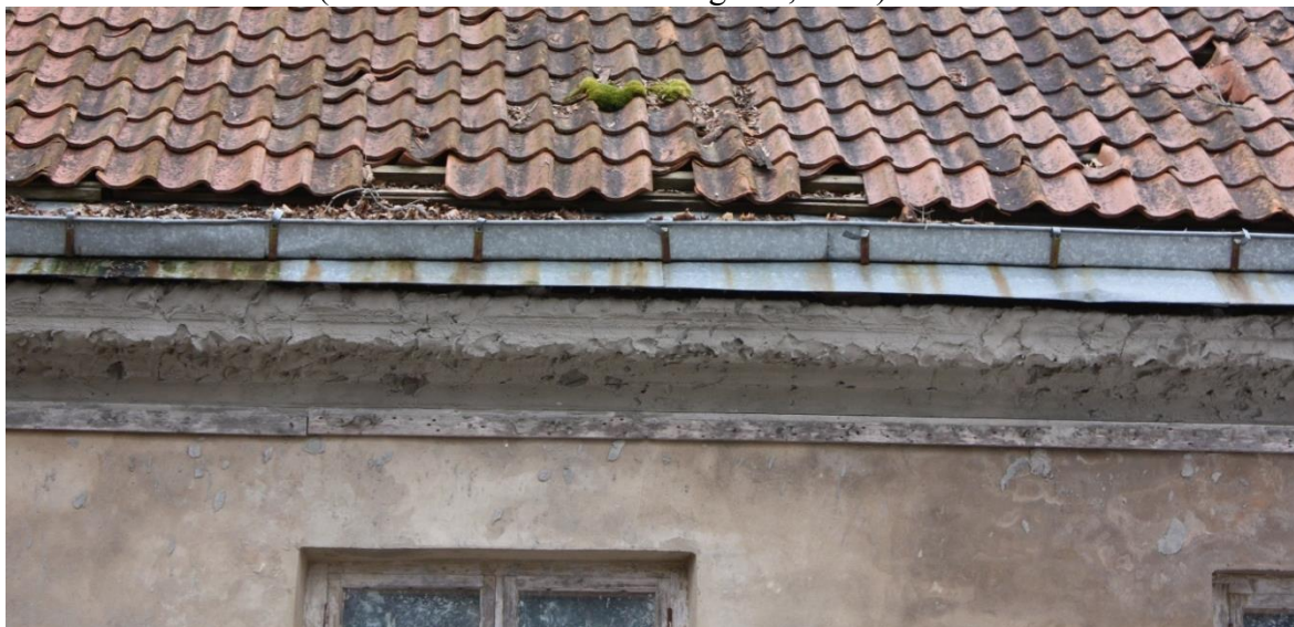
Joonis 51 – Tsementkrohviga parandatud karniis – Vali, J. fotokogu
