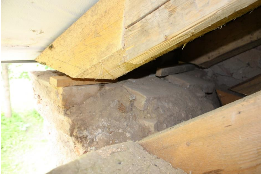
Joonis 45 – Kiilud räästatõstja ja karniisi vahel – Vali, J. fotokogu
