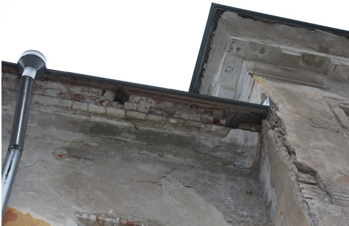
Joonis 61 – Tellistest räästakarniis paekiiviplaadil – Vali, J. fotokogu
