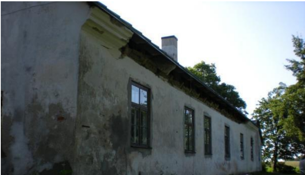
Joonis 46 – Varisenud karniis hoone lääneküljel – Niit, R. 14.07.2009
