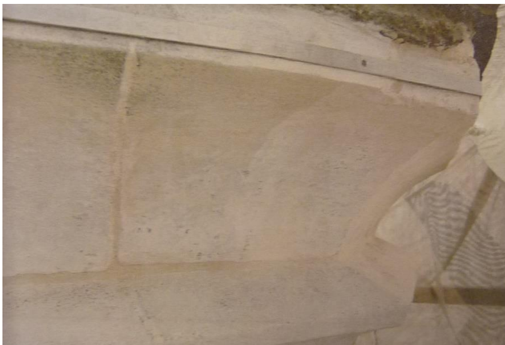
Joonis 55 – Terasest ringvöö ja Remmersi restaureerimismördiga restaureeritud karniis – Uuetalu, 2009, n9.5524B
