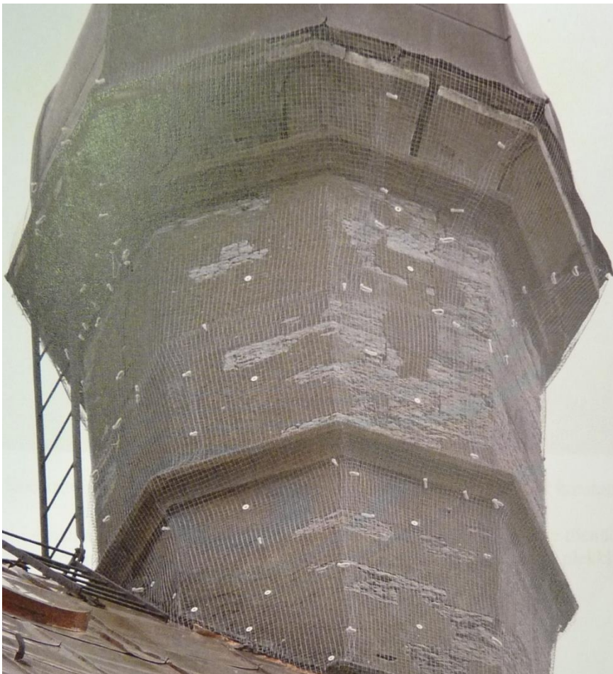
Joonis 54 – Võrkudega kaetud kesklöövi idatorn – Uuetalu, 2008, n9.5524/A
