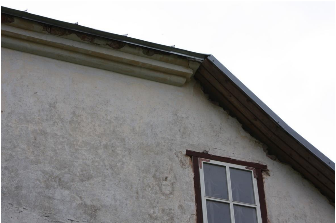
Joonis 49 – Katuse ilma karniisita viiluäär, millest katuseserv liiga kaugele üle eendub – Vali, J. fotokogu
