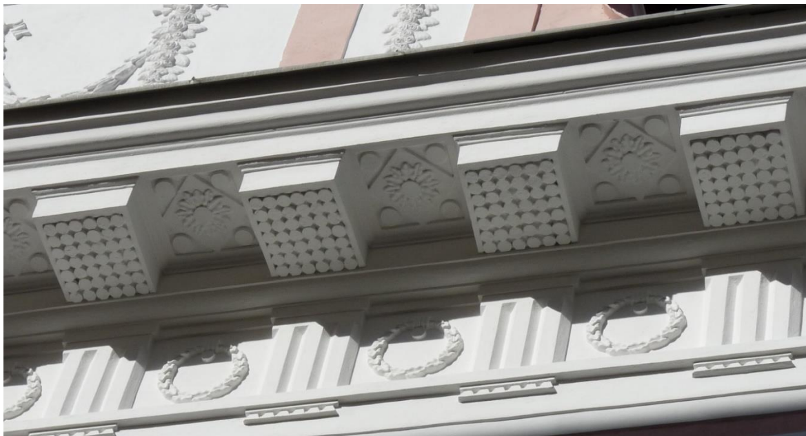
Joonis 9 – Mutul 'id gutta 'dega: Pikk 19, Tallinn – Kaaret, T. 17.03.2015
