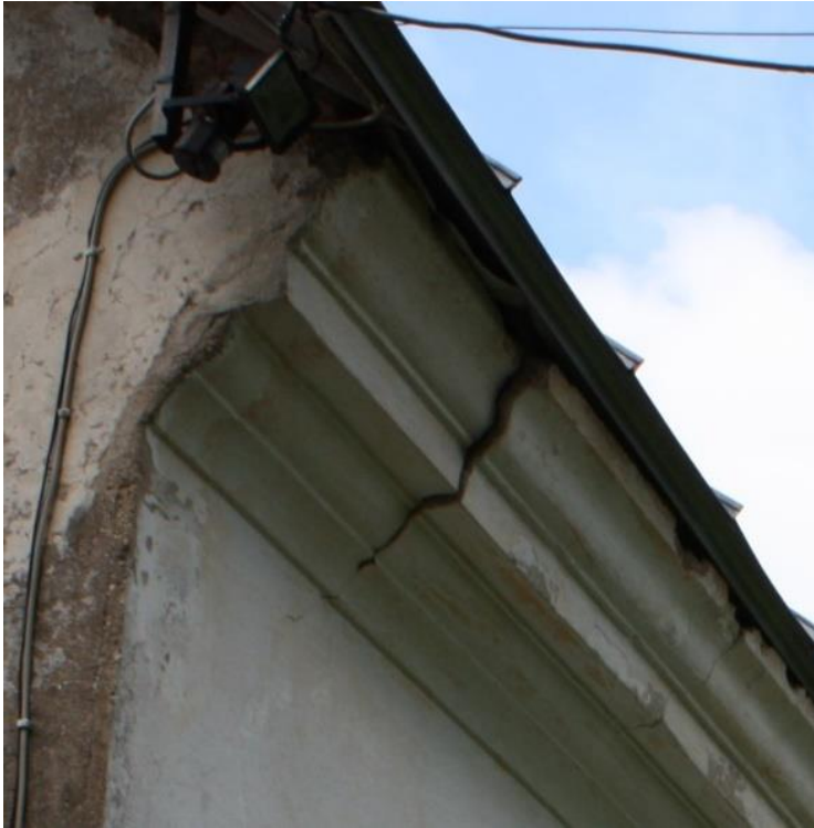
Joonis 43 – Hoone küljel välja vajunud räästakarniis – Vali, J fotokogu
