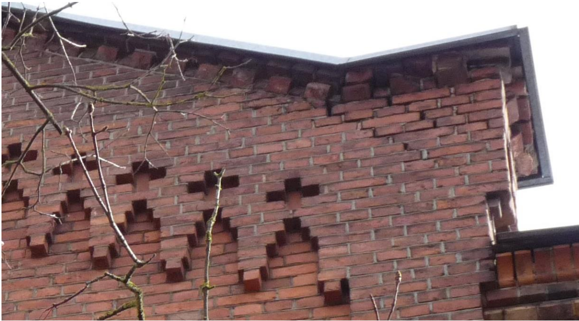
Joonis 39 – Kaldpraod viilul ja allapöördega katteplekk – Kaaret, T. 10.04.2015
