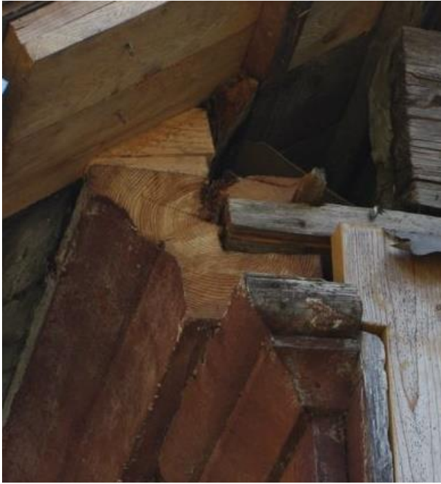
Joonis 86 – Räästakarniisi läbilõige – Vali, J fotokogu
