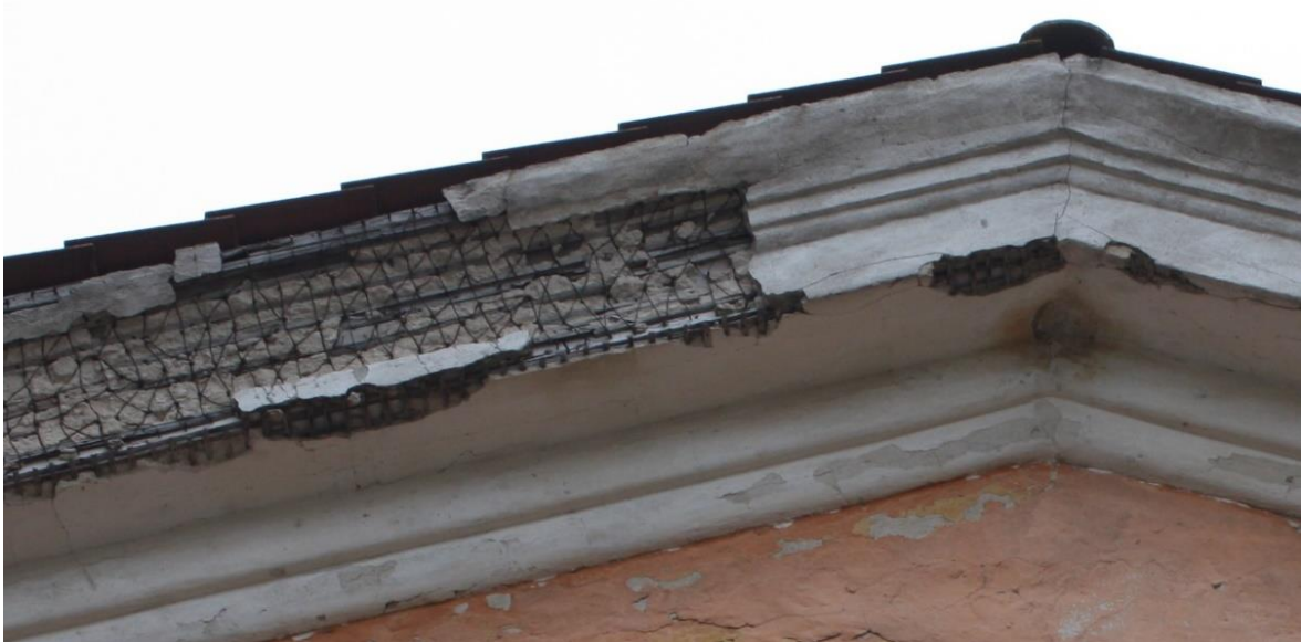
Joonis 82 – Puidul krohvitud karniis Aruküla mõisa esifassaadi kolmnurkfrontoonil – Vali, J. fotokogu
