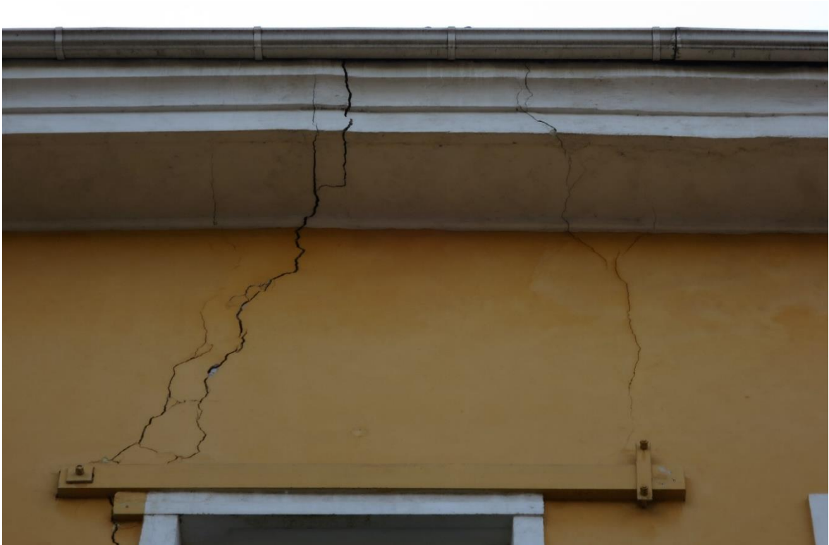
Joonis 77 – Pragu Toompuiestee-poolses otsaseinas – Idnurm, M. fotokogu
