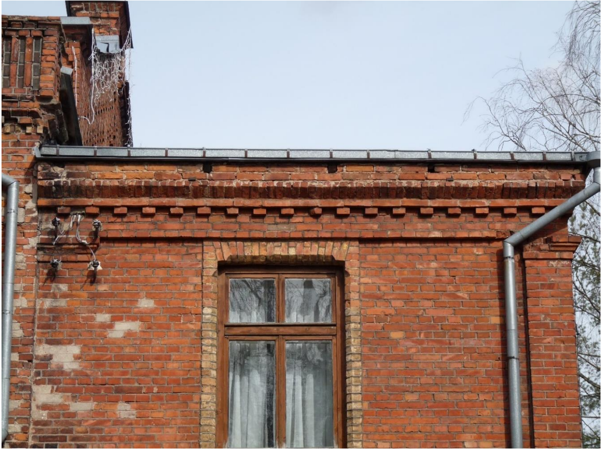
Joonis 36 – Karniisi ebaloogiline lõpetus ja sarikaotsad – Kaaret, T 10.04.2015
