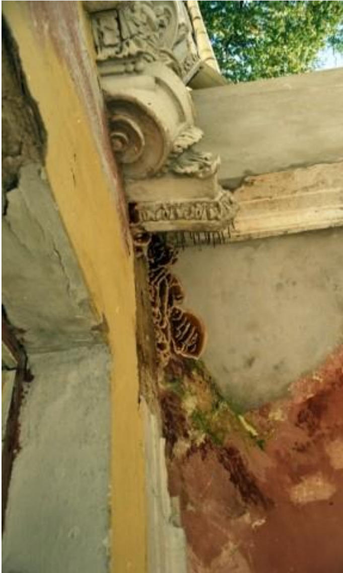
Joonis 70 – Seen Saku mõisa peahoone portikusel – Vali, J. fotokogu
