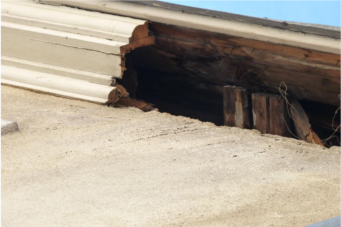
Joonis 80 – Seest tühi puidust karniis, Lai 20, Tallinn – Kaaret T. 17.03.2015
