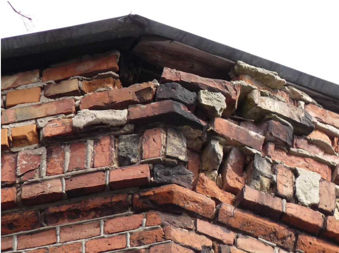
Joonis 35 – Purunenud tellised – Kaaret, 10.04.2015
