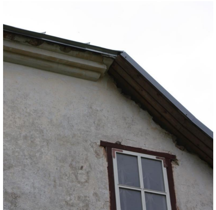
Foto 10 – Katuse karniisita viilüär, millest katuseserv liiga kaugemale üle endub – Vali, J. fotokogu
