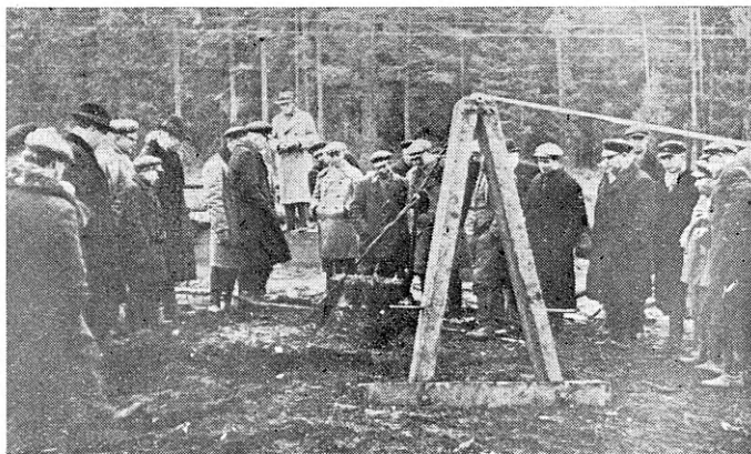
Pilt 11. Pildil näidatud, kuidas asetada vaieri pukki suuremate kändude väljatõmbamisel.
