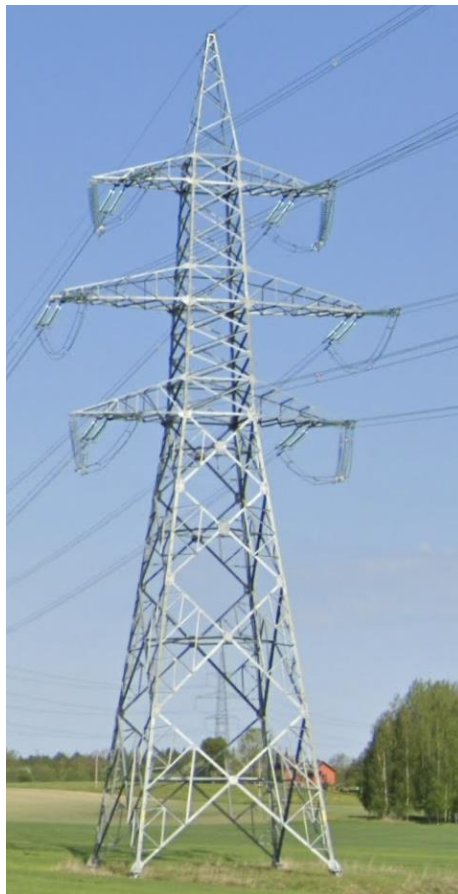
Joonis 2.2 Tüüpiline Leedu 330 kV mast kolmnurkpaigutuses [5]
