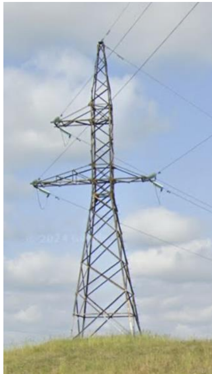
Joonis 2.4 Tüüpiline Leedu 110 kV mast kolmnurkpaigutuses [14]
