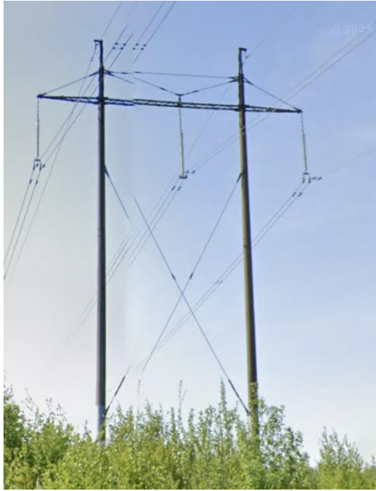
Joonis 2.3 Tüüpiline Leedu 330 kV mast horisontaalpaigutuses [13]
