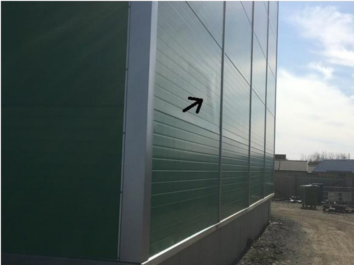
Joonis 1.8 Soojustuse küljest lahti tulnud terasleht hoone välisseina sändvitšpaneelil (Kalamees, erakogu)
