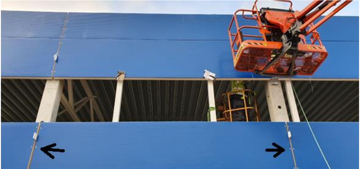
Joonis 1.9 Sändvitšpaneeli laahoone välisseinana (Autori erakogu)
