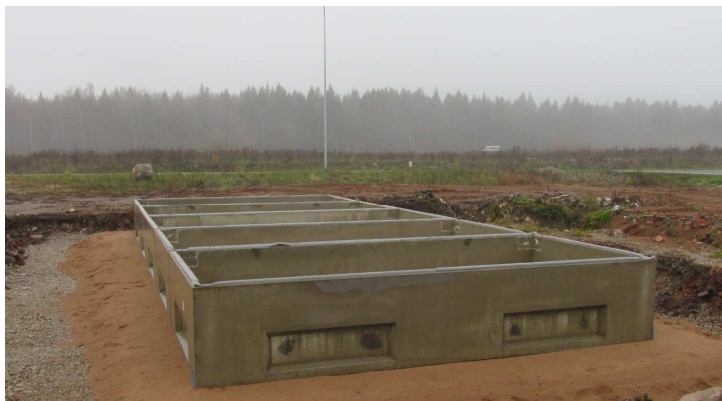
Joonis 6.2.2. Alajaama vundament
