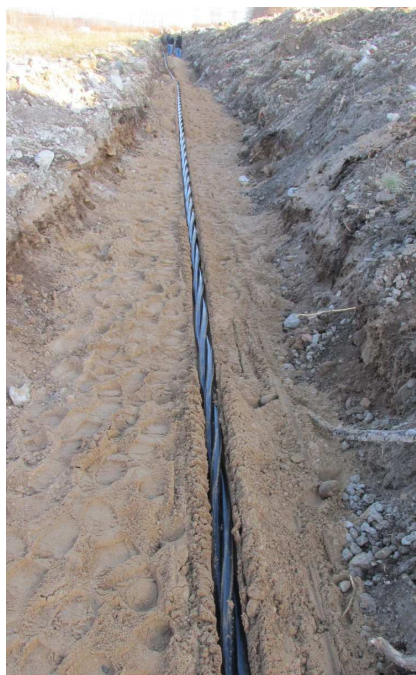
Joonis 6.2.21. Kaabli paigaldus
