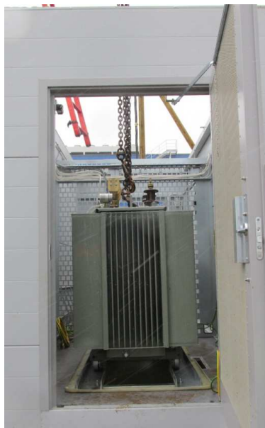
Joonis 6.2.10. Trafode paigaldus
