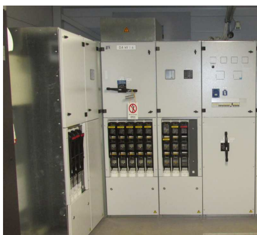
Joonis 6.2.14. 0,4 kV sektsioon
