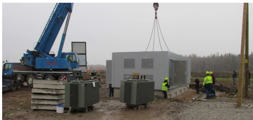
Joonis 6.2.3. Alajaama paigaldus vundamendile
