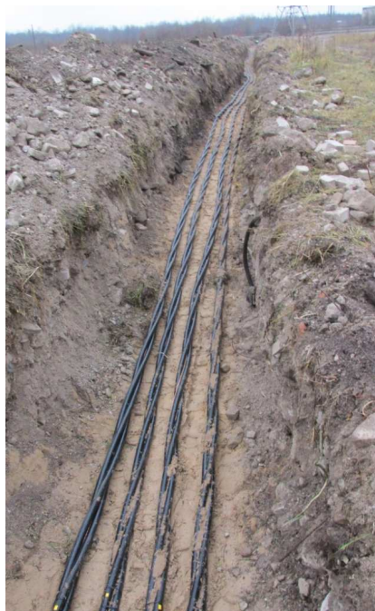
Joonis 6.2.22. Kaabli paigaldus (4 kaablit kaevikus)
