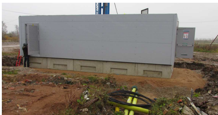
Joonis 6.2.5. Paigaldatud alajaam
