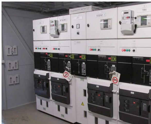
Joonis 6.2.17. 6 kV sektsioon
