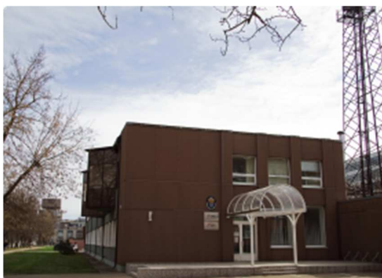
Joonis 1.2. VKG Elektrivõrgud OÜ Narva kontor
