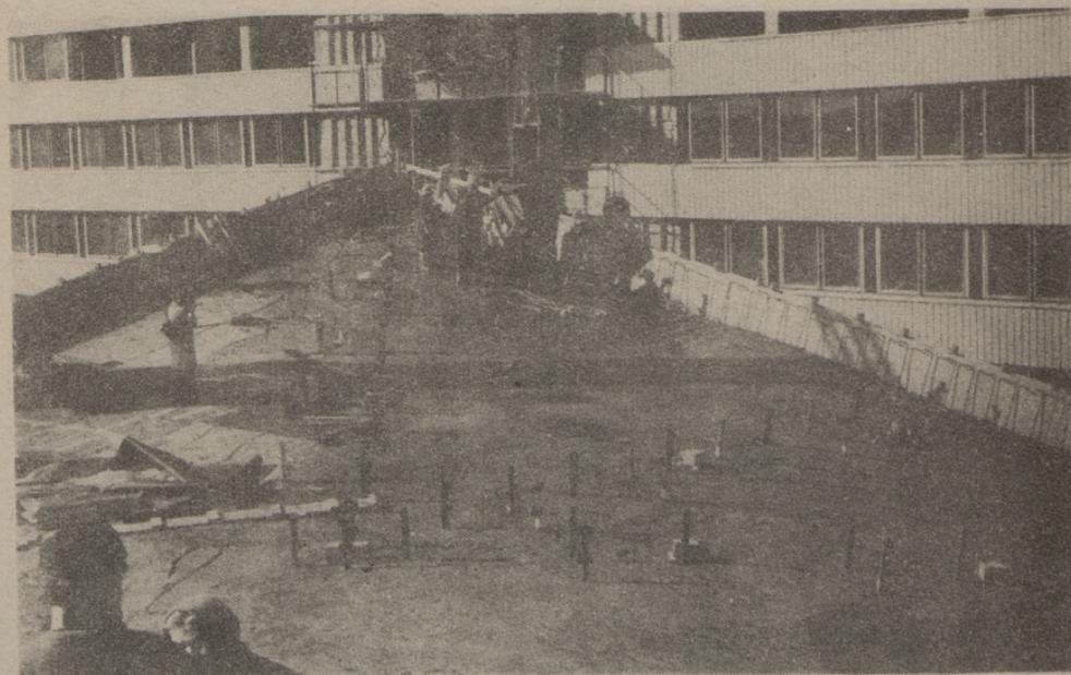
Фиг. 11. Окончание бетонирования и измерительные базы
