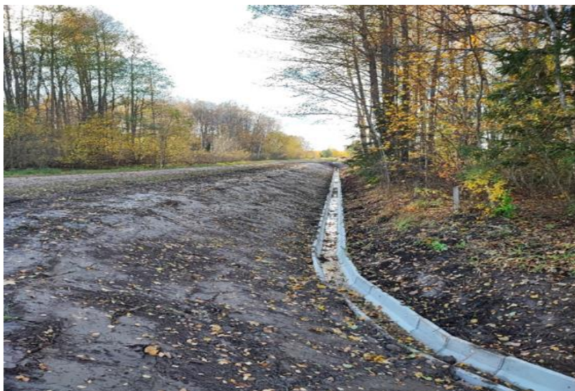
Pilt 2.6 Pärast betoonelementide paigaldamist kraavi ja tööde lõppu [6]
