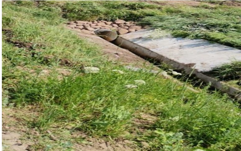
Pilt 2.8 Kindlustatud kraav betoonelementidega ja maakiviga [6]
