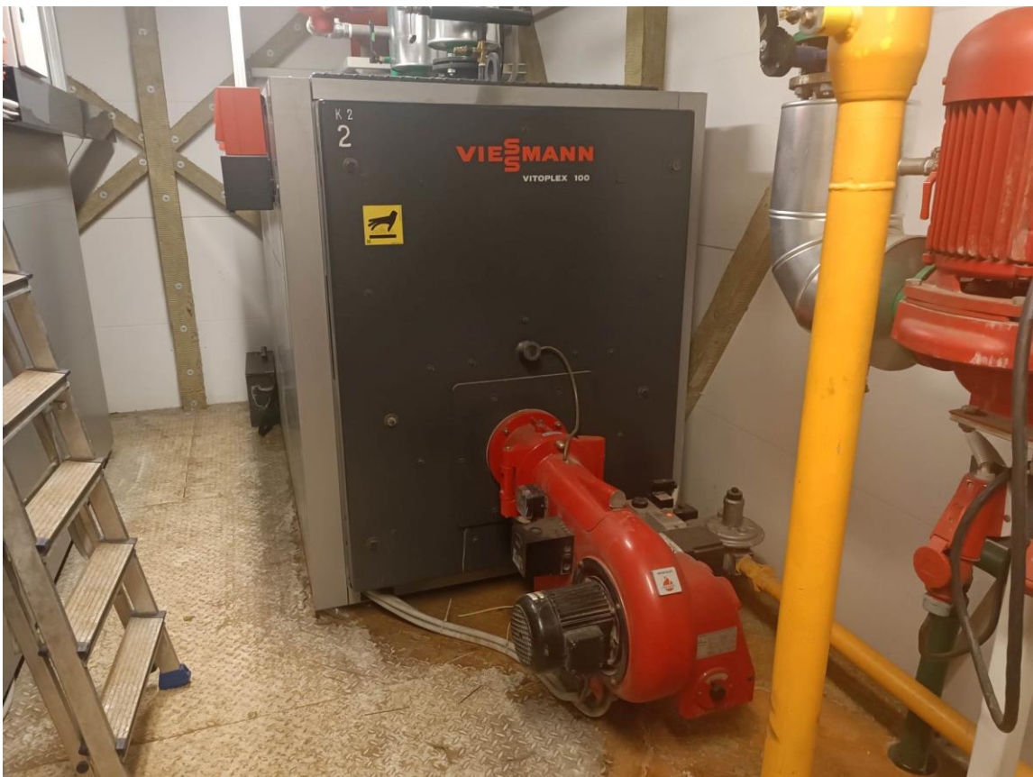
Joonis 3. Maagaasi "Viessmann Vitoplex 100" katel
