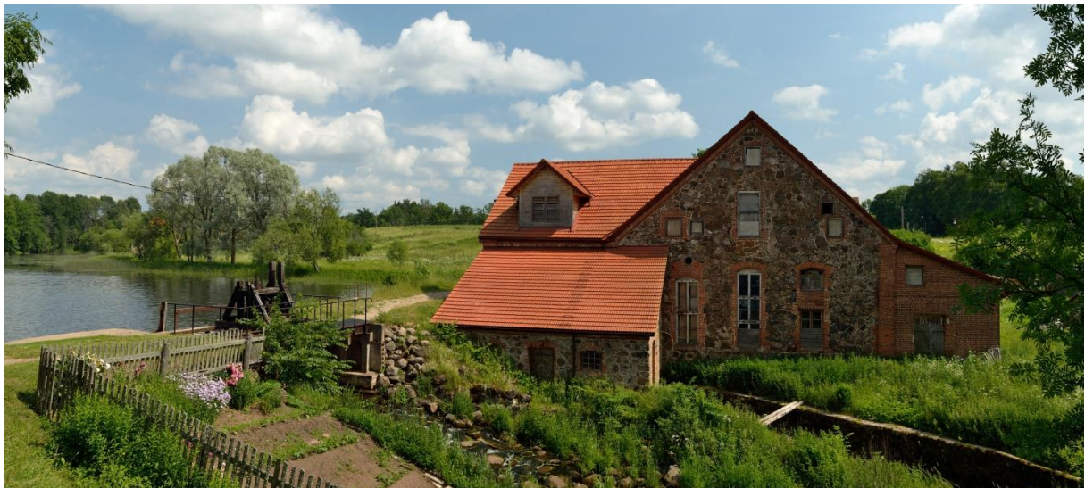
Joonis 2.5 Õisu mõisa hüdroelektrijaam [29]
