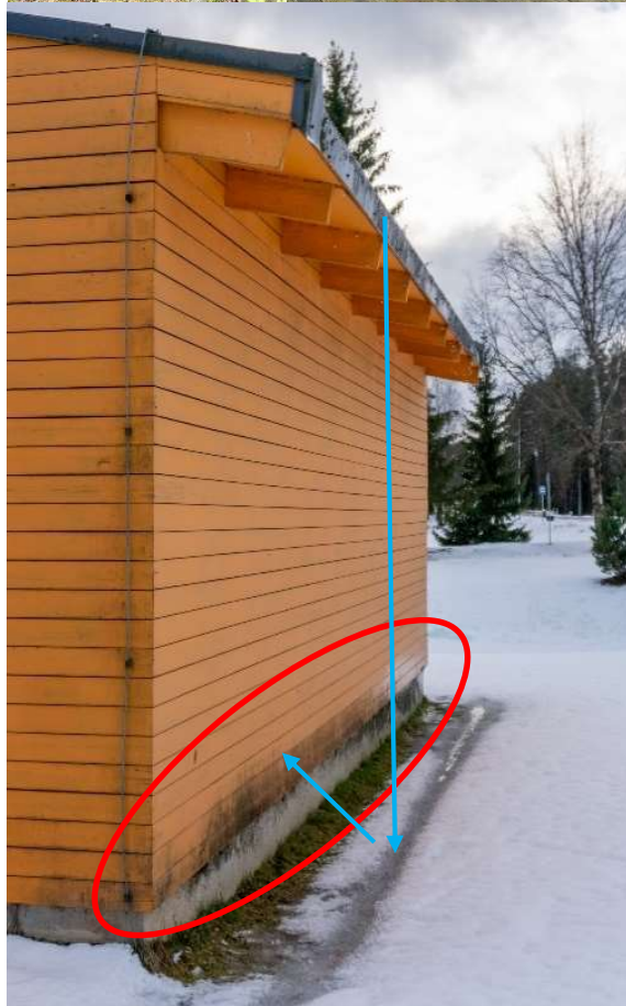
Joonis 36. Näiteid küllastatud hoonete projektilahendustest, mis on põhjustanud fassaadikattele püsivalt vee voolamist (a-c) või pritsimist (d)
