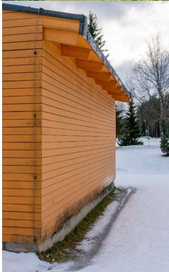
Joonis 36. Näiteid küllastatud hoonete projektilahendustest, mis on põhjustanud fassaadikattele püsivalt vee voolamist (a-c) või pritsimist (d)
