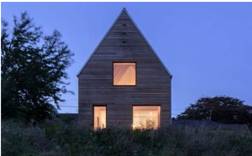
Foto 2. „Barn house“ stiilis hoone [23]
