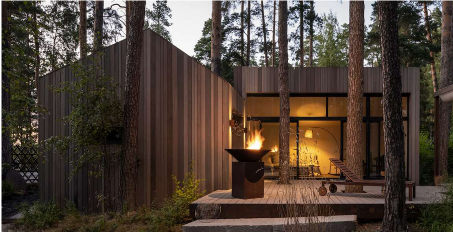
Foto 4. Ilma räästata ja soklita puhkemaja Venemaal [25]
