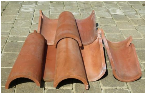
Joonis 5. Munk-nunn tüüpi katusekivid. Pealmine kivi on munk, alumine nunn.
