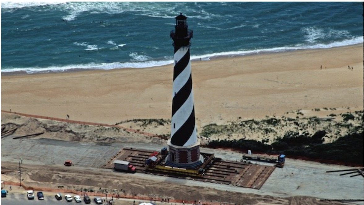
Joonis 1.4 Tuletorni transport uude asukohta [6]
