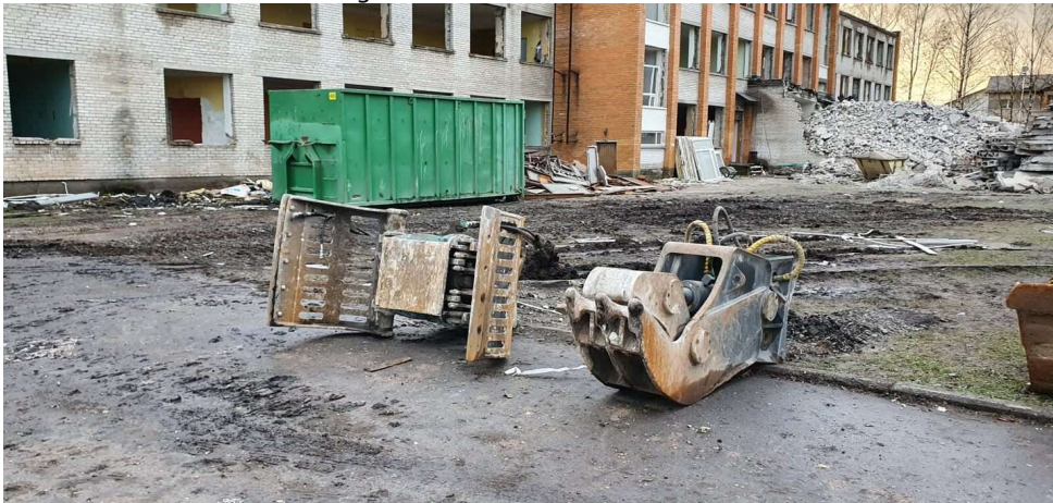
Joonis 2.4 Lammutustöödeks kasutatavad haaratsid. Vasakpoolsemat kasutati suuremate konstruktsioonelementide eraldamiseks ja lammutamiseks ning parempoolset haaratsit kasutati konstruktsioonelementide lammutamiseks väiksemateks tükkideks
