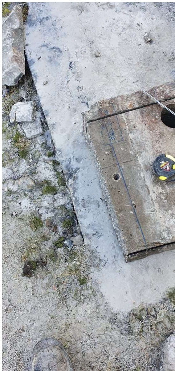
Joonis L4.3 Raudbetoontala lõikamisjoone märkimine, kus on märgata lõikejoone kõrval asetsevat teemantpuurimisseadme stativi ankrut
