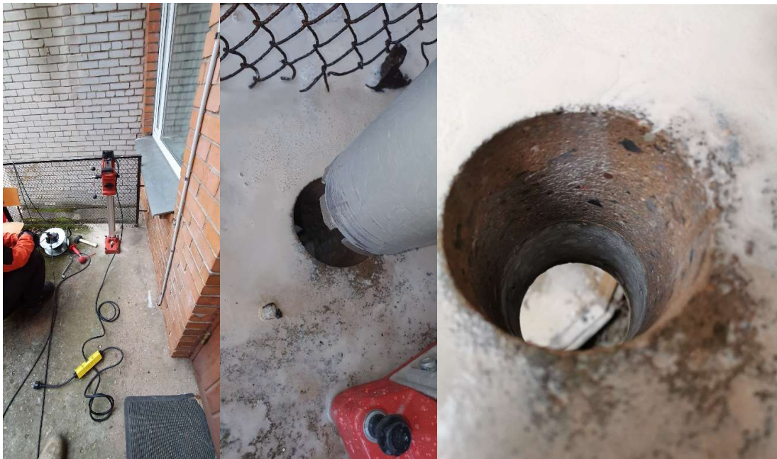
Joonis 2.9 Kärni puurimine: a) seadme kinnitamine, lisandus veel veetoitur, b) ja c) puurimise tulemus konstruktsioonis
