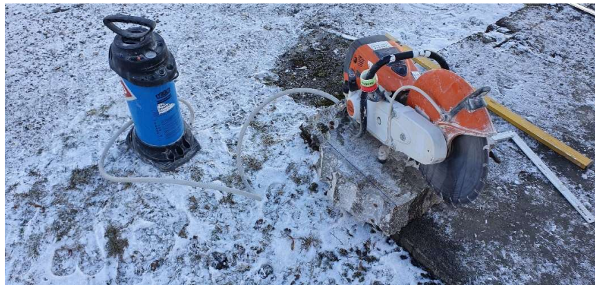
Joonis 2.11 Märg lõikamine
