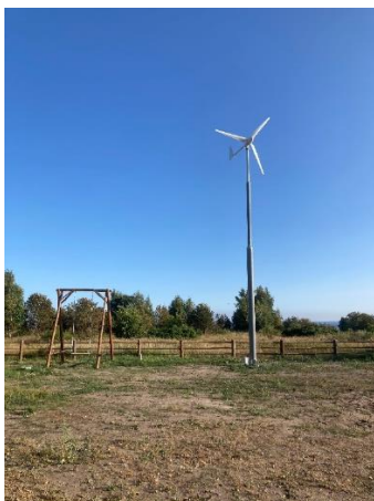
Joonis 3.23 Objektile paigaldatud tuulik
