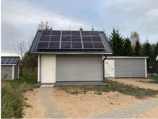
Joonis 19 Kuuri katusel paigaldatud päikesepaneelid
